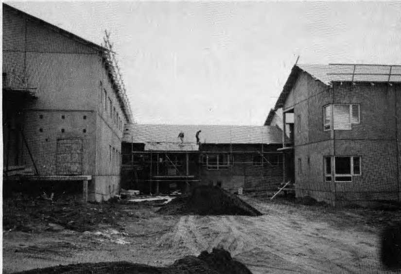
Figur 1. Krokoms sjukhus. Solväxlare monteras på taket till lågdelen mellan byggnad B och C.
