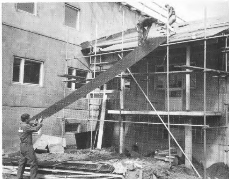
Figur 3 Krokoms sjukhus. Montage av solväxlare.
