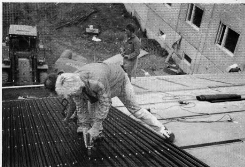
Figur 4 och 5. Krokoms sjukhus. Montage av solväxlare.
