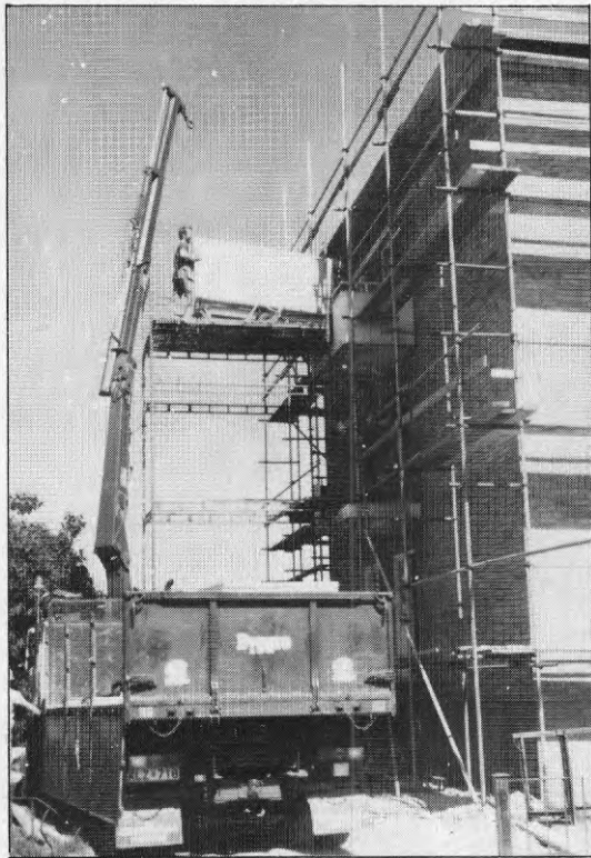
Fig 7. Bunten styrs in direkt på vagnen.
