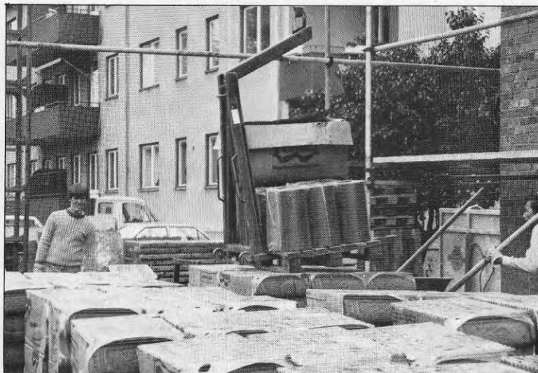
Fig 36. Pallgaffel för lyft upp till 2,5 ton.
