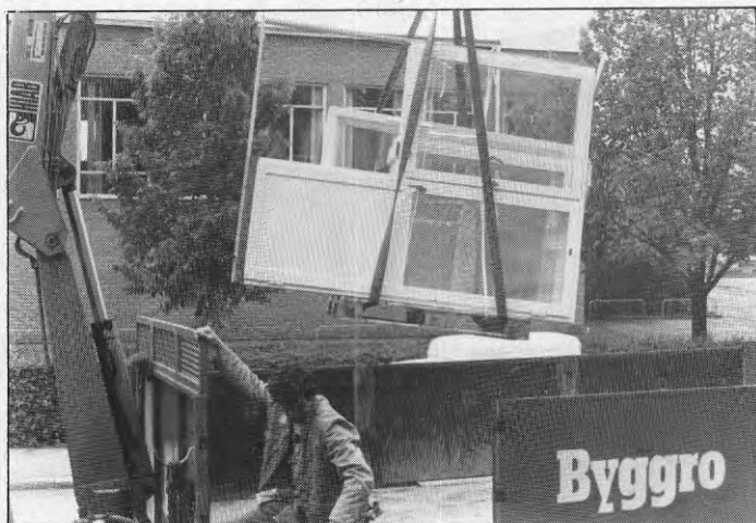
Fig 16. Pallen lyfts med bilens kran.
