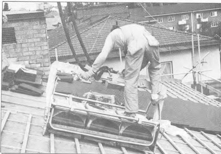
Fig 34. Lösgöring av pannstuv från lyftgaffel.
