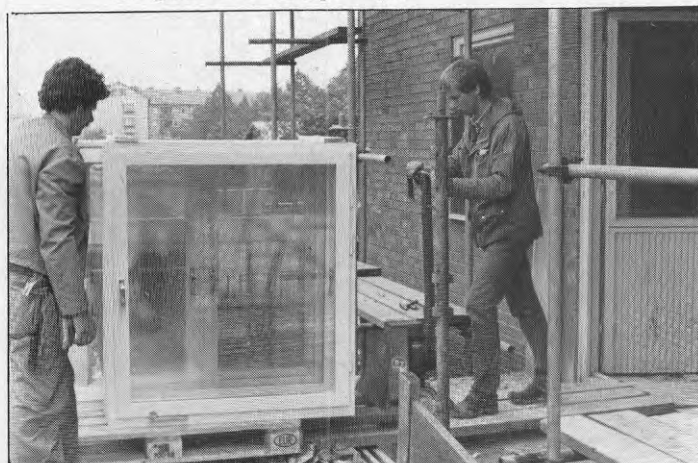
Fig 17. På landgång körs pallyftaren ut och hämtar pallen.
