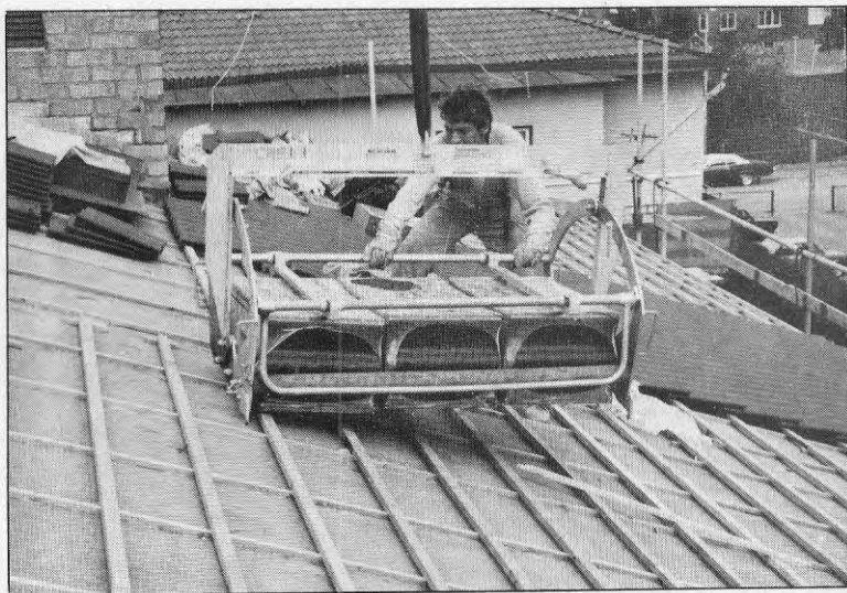
Fig 33. Lossning på tak av 3x27 pannor nära själva läggningssytan.
