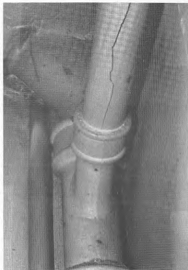
Figur 6.4 Sprucken grenledning
