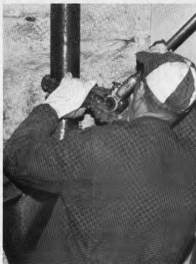
Figur 6.5 Kapning av stamledning med rörkap
