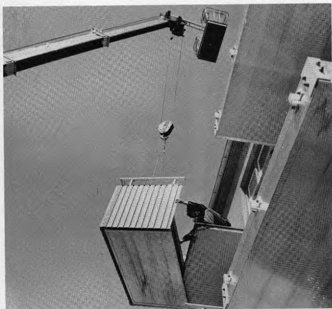
Figur 10. Montering av Foga-balkong
