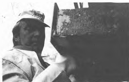
Figur 23. Montering av AD-kantprofil, som bildar den reparerade balkongens nya kant.
