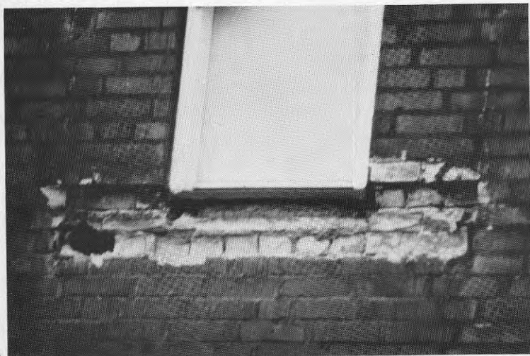
Figur 8. Bild efter utförd traditionell rivning.
