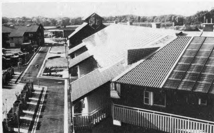
Figur 7.16 Färdigmonterad solfångare.
