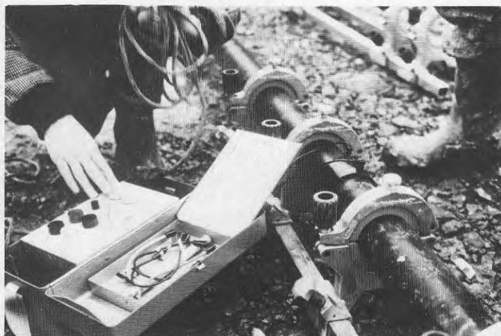
Figur 7.8 Sammanfogning av PEM-rör (DN 90) med muff, fixtur och elaggregat.
