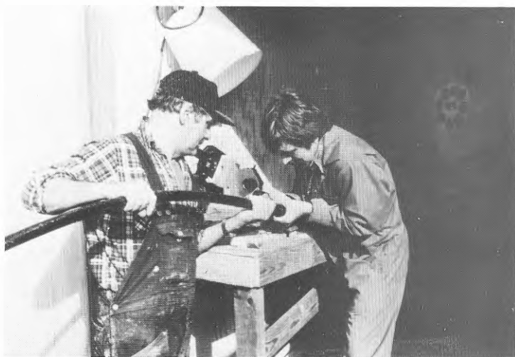
Figur 7.2 Sammanfogning av rördelar.
