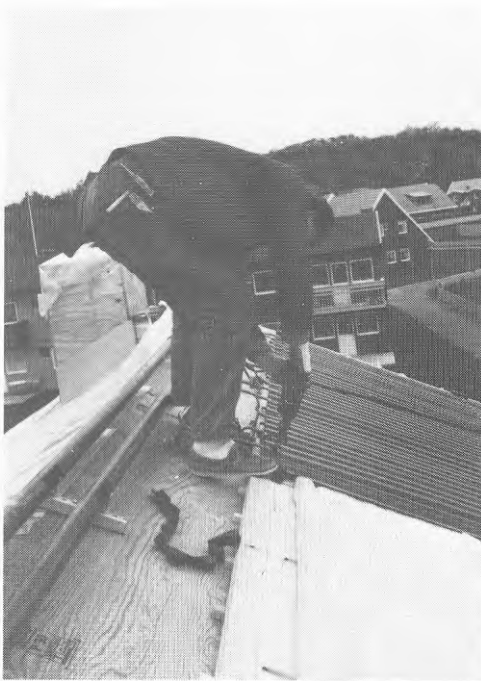
Figur 7.12 Montering av absorbator.
