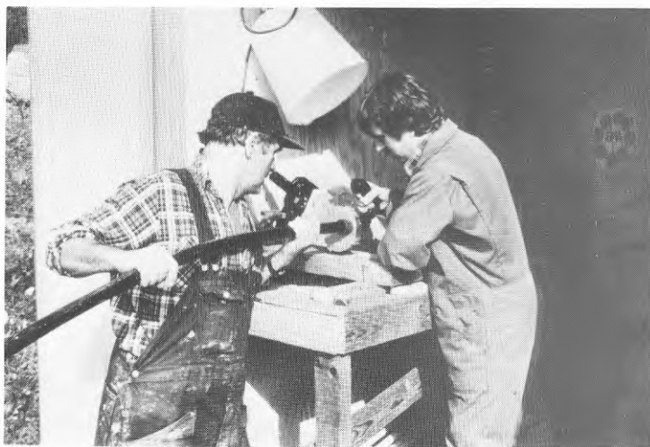
Figur 7.1 Smältning av kontaktytor, m.h.a. elvärm� svetsapparat, vid "U"-böjen.
