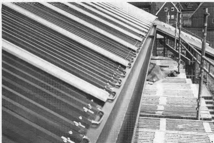
Figur 7.13 Nedre delen av solfångare.
