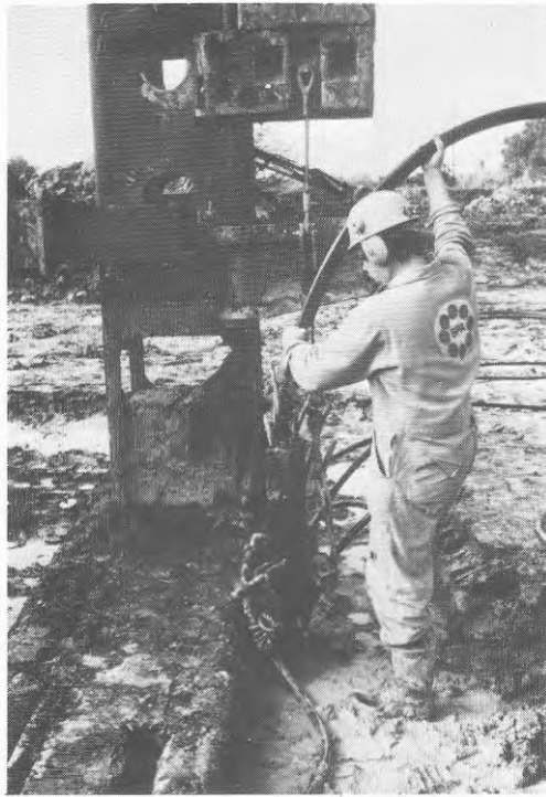
Figur 7.3 Placering av PEM-rör i påle.
