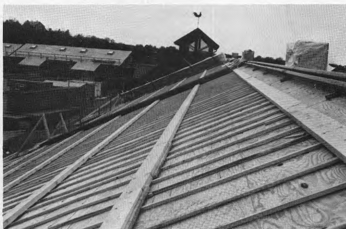
Figur 7.10 Läkt för förstärkning av plyfaskivor.
