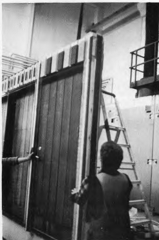
Figur 5.5.d Monterad vertikal fogstättning
