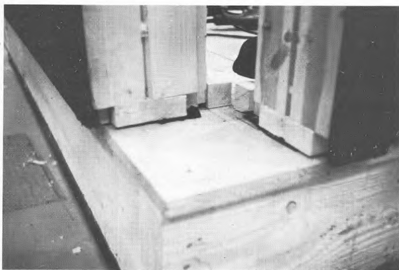
Figur 5.5 c Monterad sylttätning
