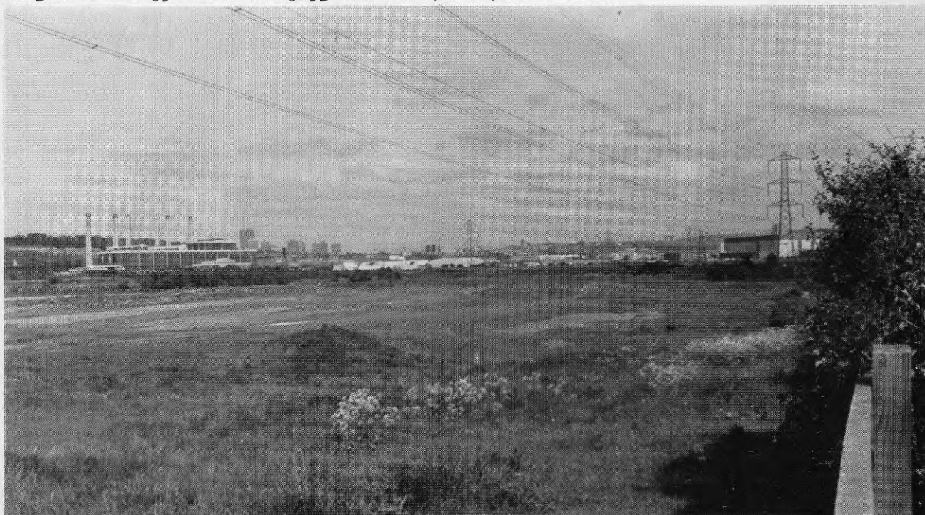
Figur 74. Utfyllnad med flygaska har påbörjats, 1983.
