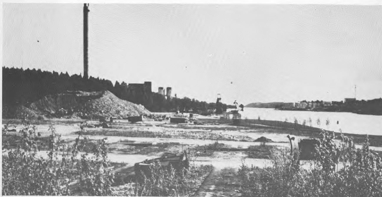
Figur 84. Igelstaområdet. Tillfälligt utnyttjas delar av området för upplag. 1983.
