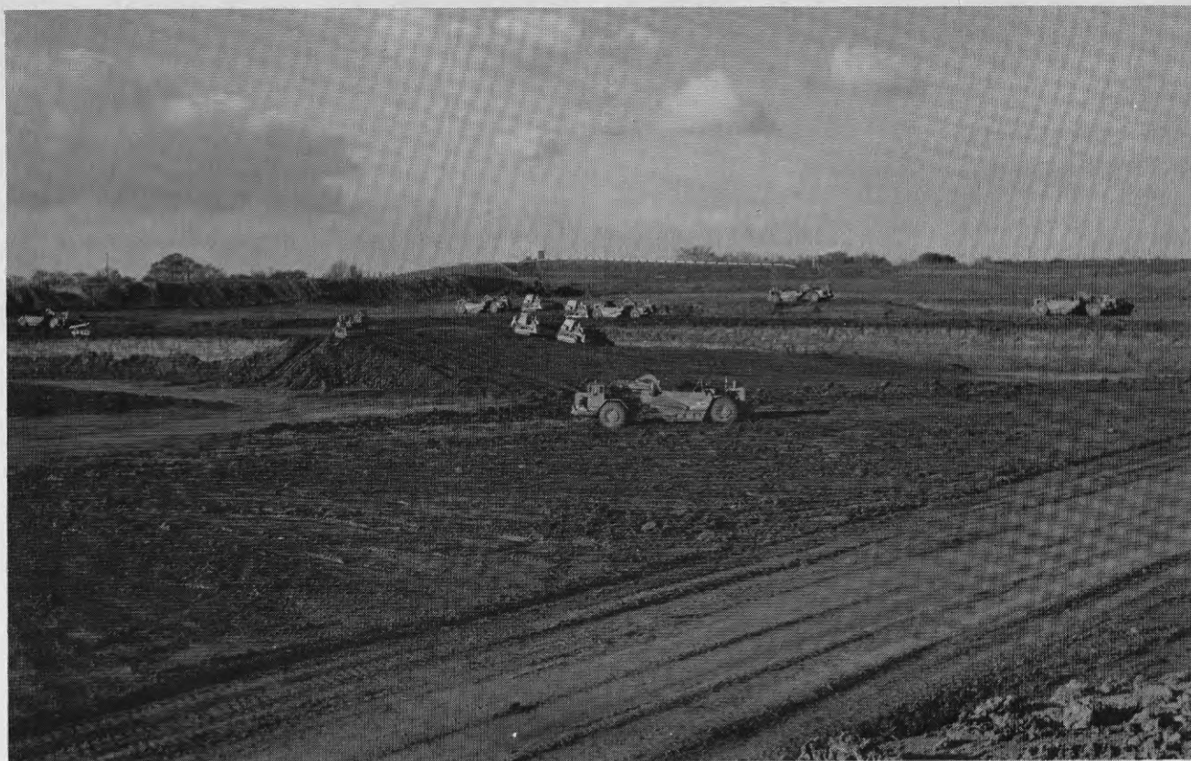
Figur 71. Efterbehandling med jordtäckning pågår i en del som fyllts med aska.
