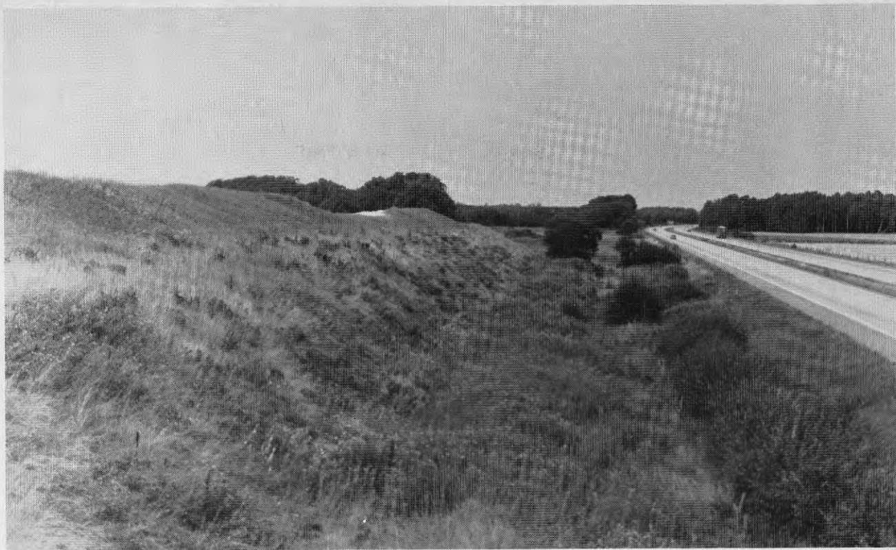
Figur 53b. Industriavfallsupplaget från riksvägen. Upplaget har här invallats och planterats.
