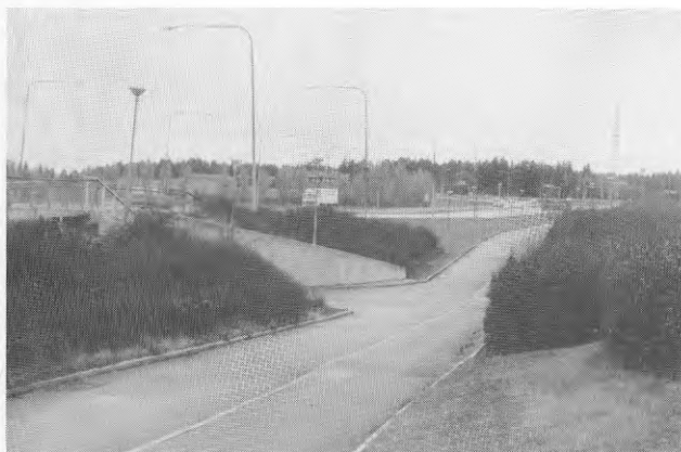
Gångtunnel under Västergatan via Årby till Årby naturreservat.
