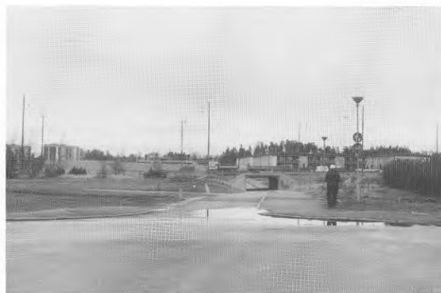
Gångtunnel under E3
