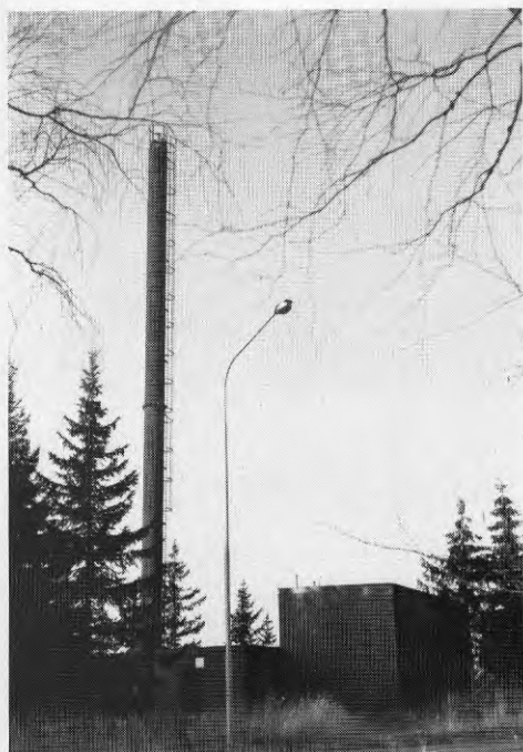
Figur 14 Värmepumpbyggnad (höjden beror på förångarnas storlek).
