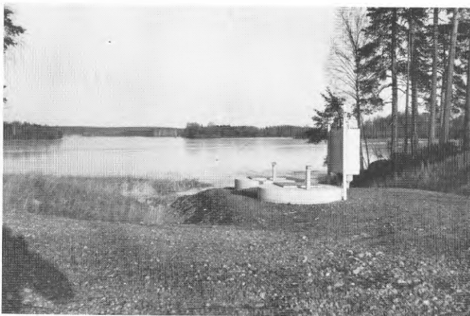
Figur 12 Sjön Ösjön. I förgrunden pumpstation.
