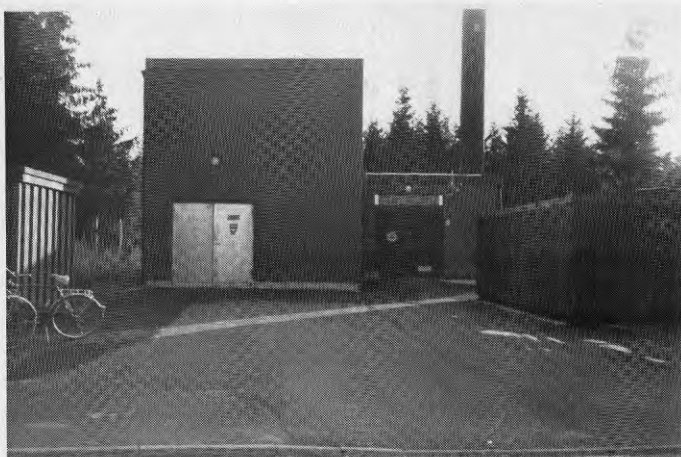
Figur 13 Värmepumpbyggnad och befintlig oljecentral (hus med skorsten).
