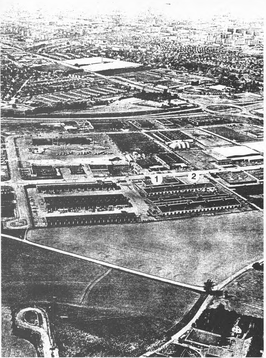
Bild 3.53 Fosie industribys läge i förhållande till omgivande bebyggelse. Servicehusets första och andra etapp är markerade med (1) och (2)
