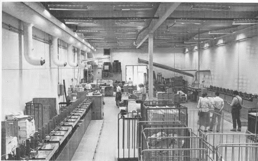
Bild 3.43 Takhöjden utan entresolplan är 5,0 meter.
