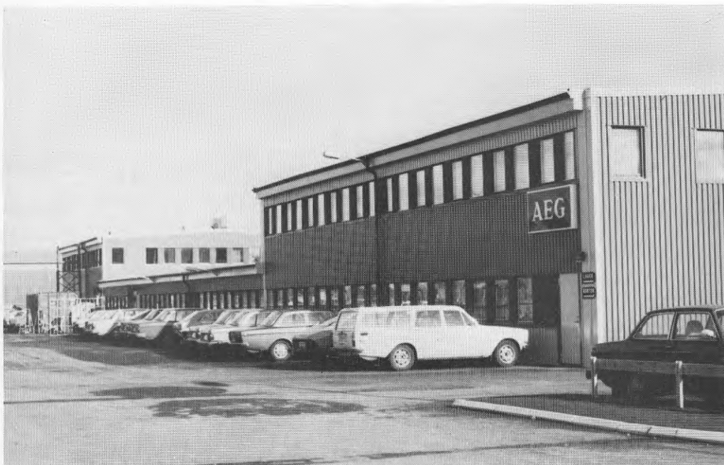
Bild 3.17 Parkeringsplatserna i direkt anslutning till företagen är otillräckliga
