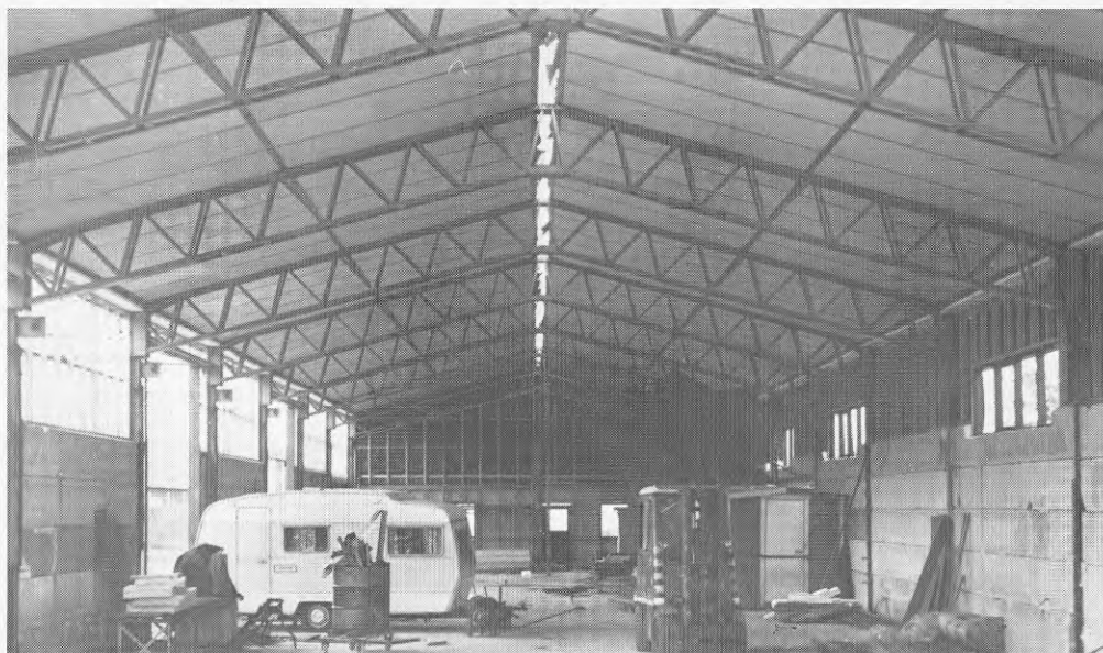
Bild 3.51 Stålstommen i Sävelund
