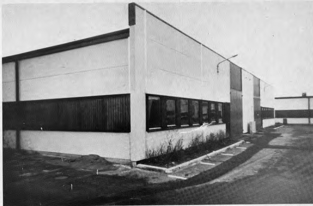
Bild 3.26 Bilden visar de förberedda möjligheterna att förse byggnaden med flera fönster.
