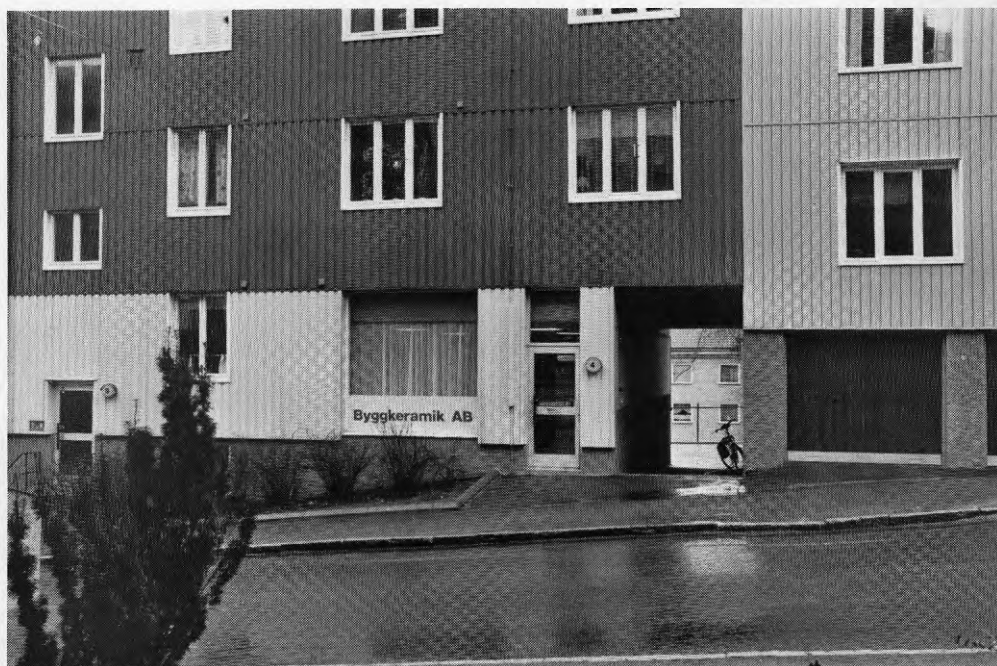
Bild 3.14 Bygggeramikföretagets tidigare lokaler i bottenvåningen till ett bostadshus
