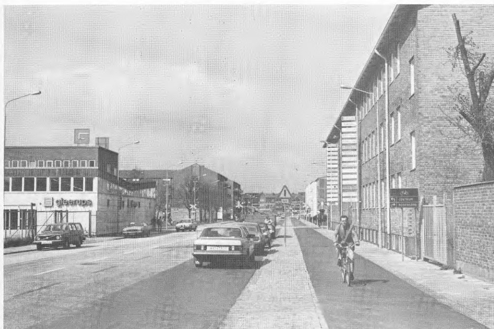
Bild 3.28 Annelund är beläget i nära anslutning till bostäder
