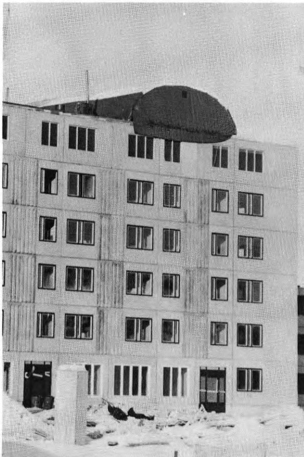
FIG. 35. För att klara pappläggning vintertid måste värme tillföras. Detta kan ske i ett tält, som flyttas över takytan.
