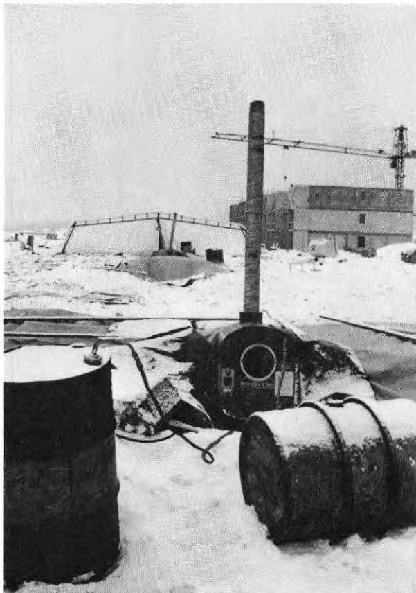
FIG. 9. En tämligen vanlig åtgärd för att tina tjäle i mark var att föra in varmluft under presenningsintäckning.
