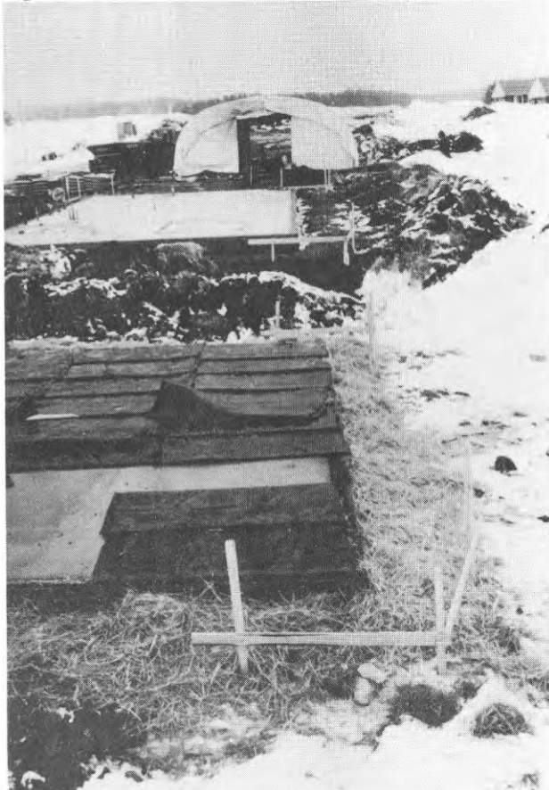
FIG. 7. För att tina tjäle och skydda konstruktionerna i mark kan värmeslingor användas. En metod är att lägga ut plastslang i vilken man låter varmvatten passera. Vattnet kan värmas upp i värmväxlare intill byggplatsens ångpanna. I detta fall har man lagt ut slingorna med c/c 80 cm för att i första hand tina tjäle i schaktbotten. I ett senare skede fungerar utrustningen som skydd mot tjälnedträngning.
