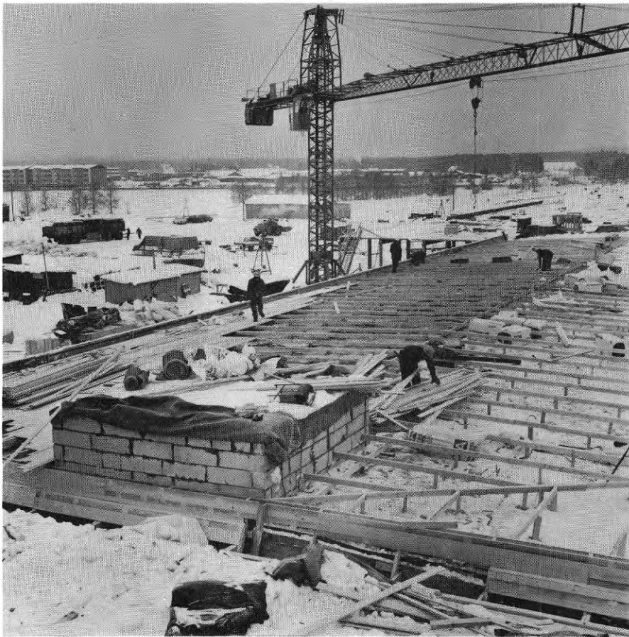
FIG. 34. Vid takarbeten vintertid måste nederbörden hindras att tränga ned i den öppna konstruktionen. Snön kan bli kostsam att få undan om den kommer med på utlagd isolering och i fackverkskonstruktionerna.
