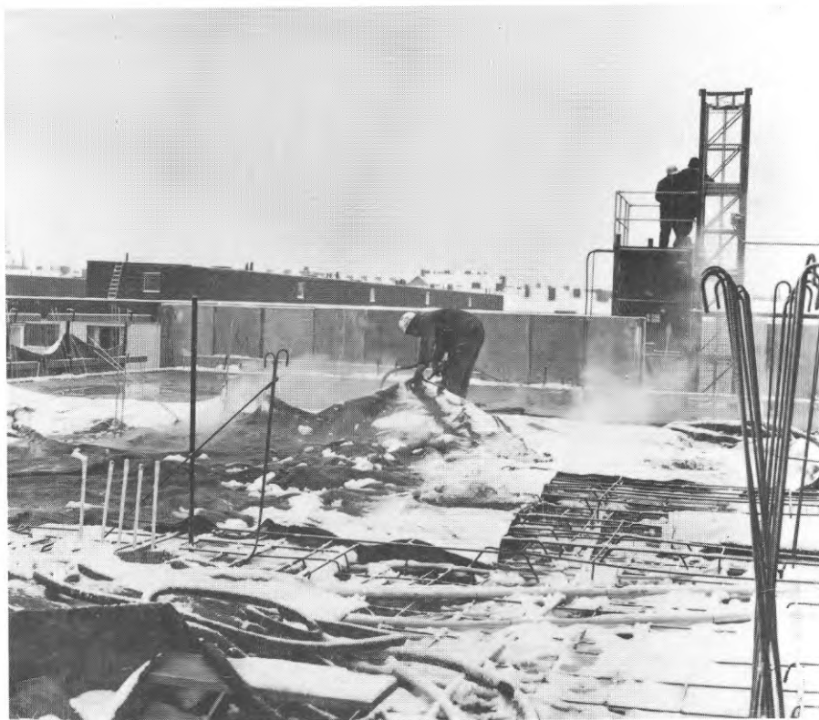
FIG. 25. Ånga är ett bra snöröjningshjälpmedel på ett vinterbygge, men bör användas sparsamt. Att torka ut fukt som bildats vid ångningen är dyrbart.
