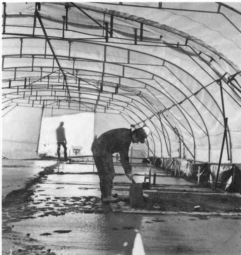
FIG. 13. Vid arbete med hela grundplattor på mark använder man ofta tält - speciellt vid småhusgrunder. Kvaliteten och utformningen på tältet kan variera kraftigt. Vid de objekt där man använder intäckning vid upprepade tillfällen kan det vara god ekonomi att skaffa tältsektioner av god kvalitet.
