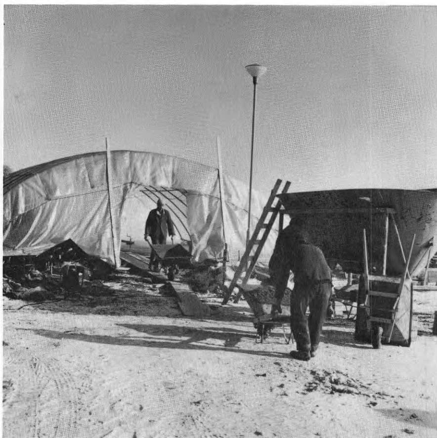
FIG. 23. Hel grundplatta för småhus utförs ofta som enskiktsbjälklag. Tältet kan stå över grunden under tiden för tjältning, arbeten med armering och installationer samt under betonggjutningen.
