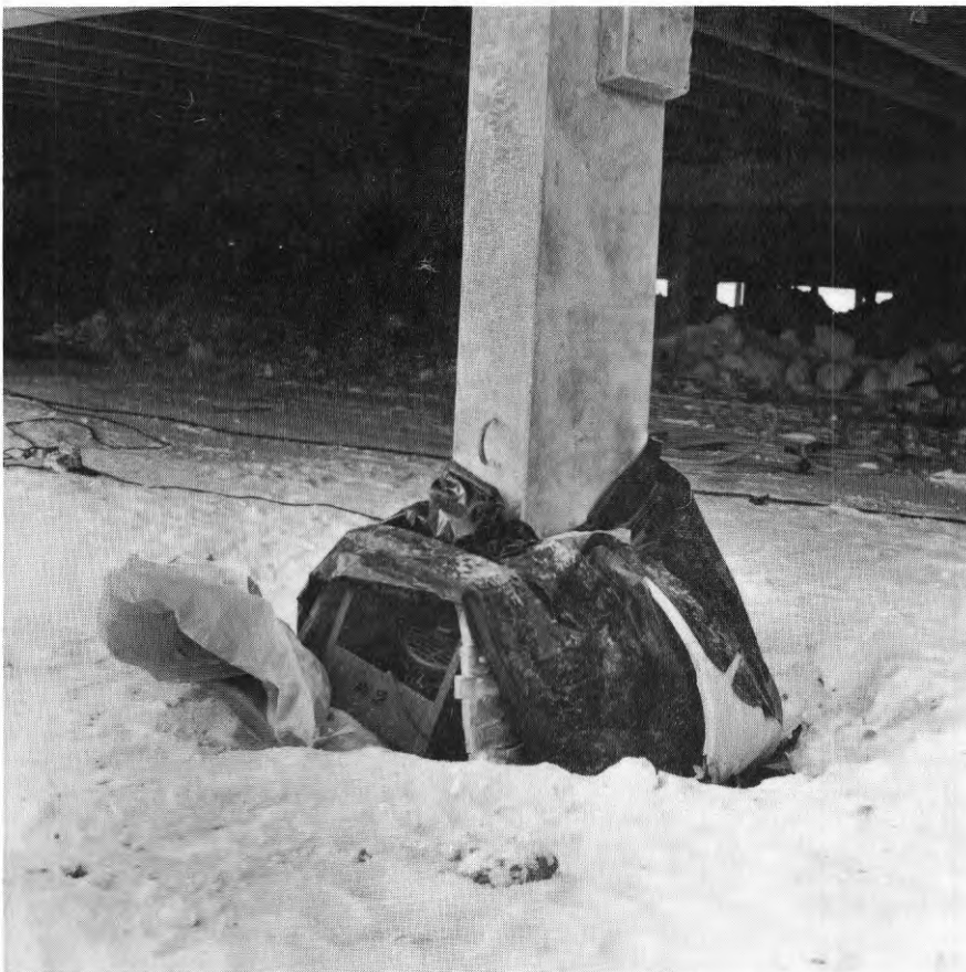
FIG. 27. Lastöverförande fogar måste värmas. Elaerotemper kan sättas in under intäckning runt fogen. En liten volym är billigare att värma än en stor.
