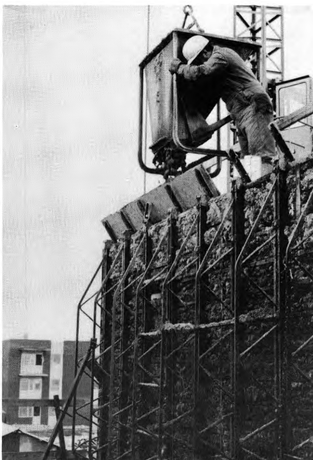
FIG. 18. Vinteråtgärderna avpassas ofta till byggmetoden. Vid arbete med enskiktsbjälklag måste man skydda betongen mot kyla och snö på ett tidigt stadium. Tält kan vara lösningen. Det måste vara avpassat så att arbete kan utföras inunder. Även om denna vinteråtgärd är kostsam kan det totalt sett vara en fördel att få slipa golvet i samband med gjutningen.
