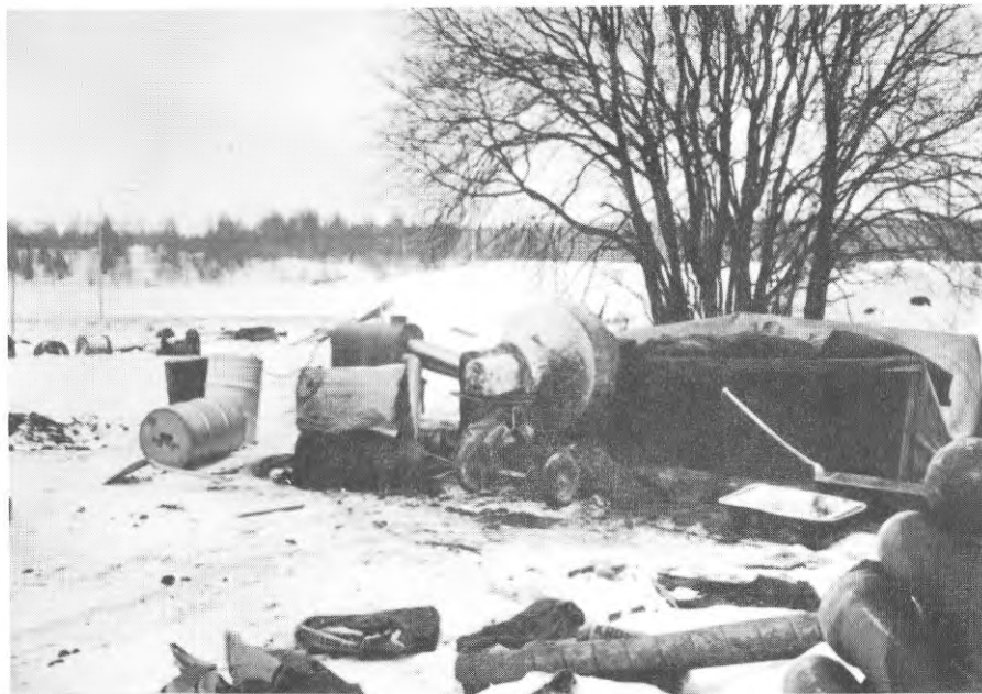
FIG. 30. Den vanligaste metoden att värma sand är med ånga. Bland övriga uppvärmningsmetoder märks varmluft från byggtork. Ofta täcker man då in sandhögen med presenning.
