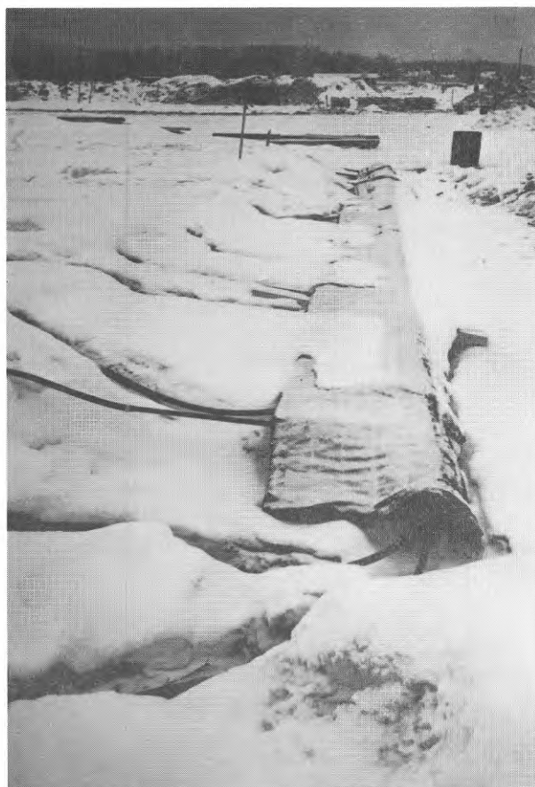
FIG. 15. Djupa utfyllningar under grundkonstruktioner kan medföra svårigheter vintertid. Det förekommer ofta att man får arbeta med tjälat material. Upptining eller intäckning kan bli tidsödande och kostsam.
