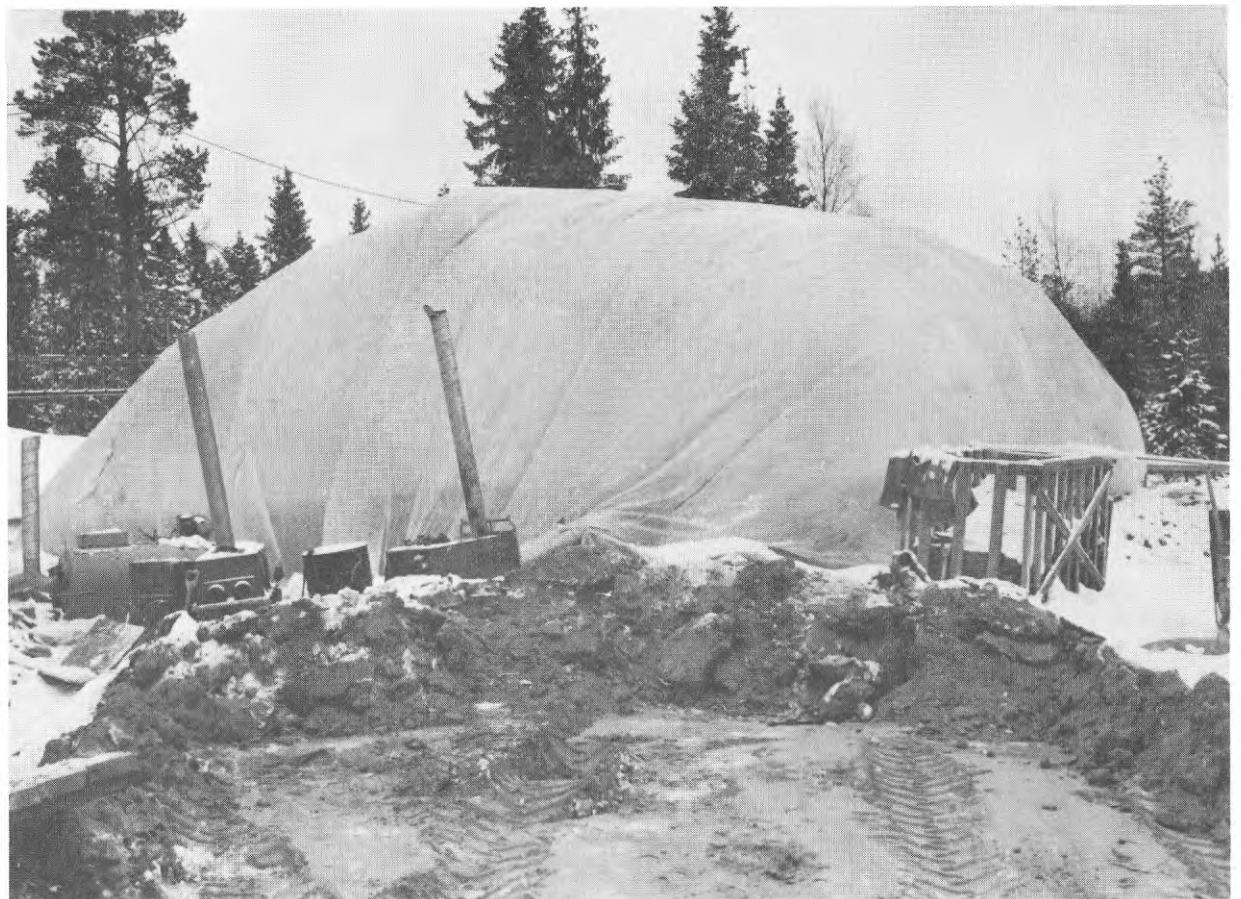
FIG. 12. Som skydd för vissa betong- och markarbeten kan det räcka med tunn plastfolie, som hålls uppe av övertrycket från inbläst varmluft. Plastfolien har förankrats med schaktmassor i nedre kanten.
