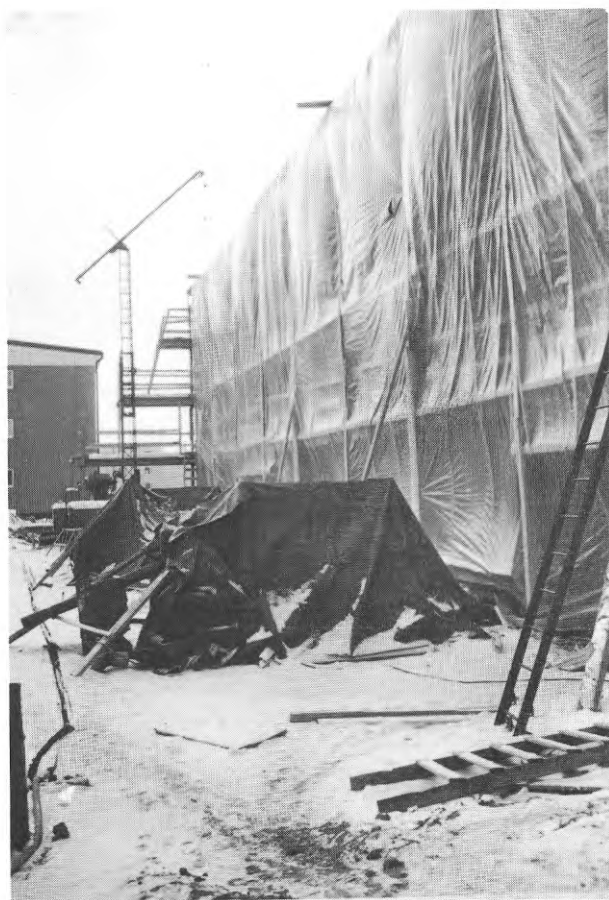
FIG. 31. Putsning av fasader måste utföras i varmt utrymme. Byggnadsställningen har klätts in med plastfolie. Byggtorkar är placerade i nedre delen av intäckningen.
