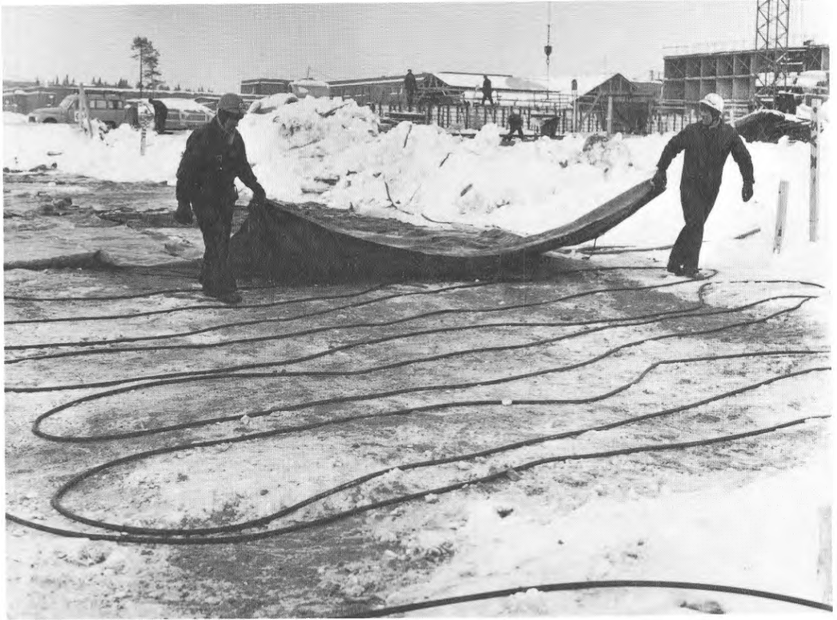
FIG. 7. För att tina tjäle och skydda konstruktionerna i mark kan värmeslingor användas. En metod är att lägga ut plastslang i vilken man låter varmvatten passera. Vattnet kan värmas upp i värmväxlare intill byggplatsens ångpanna. I detta fall har man lagt ut slingorna med c/c 80 cm för att i första hand tina tjäle i schaktbotten. I ett senare skede fungerar utrustningen som skydd mot tjälnedträngning.
