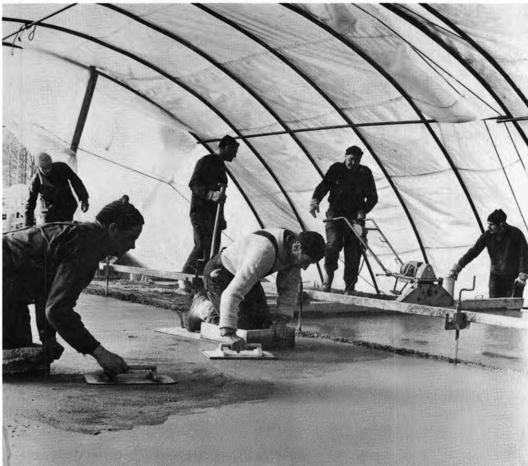
FIG. 18. Vinteråtgärderna avpassas ofta till byggmetoden. Vid arbete med enskiktsbjälklag måste man skydda betongen mot kyla och snö på ett tidigt stadium. Tält kan vara lösningen. Det måste vara avpassat så att arbete kan utföras inunder. Även om denna vinteråtgärd är kostsam kan det totalt sett vara en fördel att få slipa golvet i samband med gjutningen.
