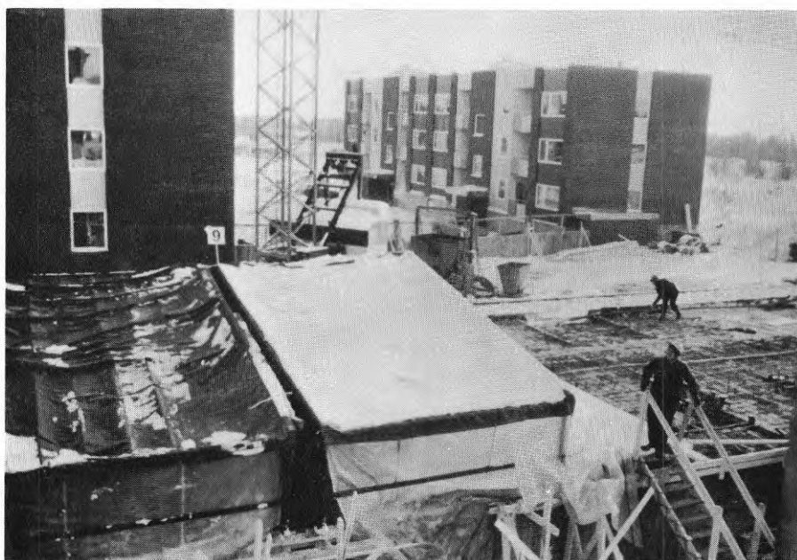
FIG. 22. Vid gjutning av enskiktsbjälklag för flerfamiljshus täcks vanligen bjälklaget med tältsektioner sedan grovgjutningen utförts. Storleken avpassas så att det kan flyttas med tornkran och så att det medger tillräckligt arbetsutrymme.
