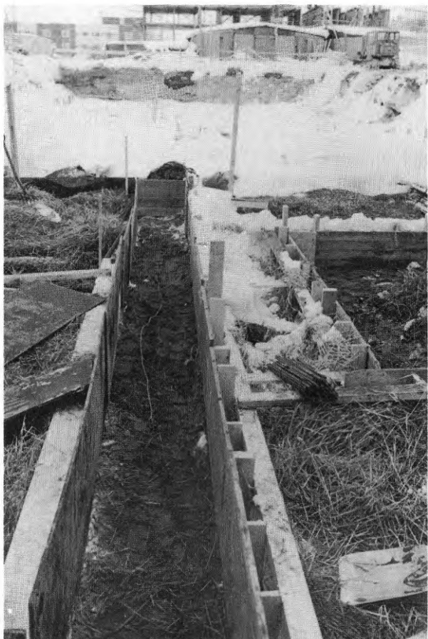
FIG. 10. En typ av värmeslinga för tjältining och skydd av färdiga konstruktioner är elkabel som läggs ut på schaktbotten. I detta fall tinades tjäle före gjutning av grundsulor. Med effekten 20 \text{ W/m}^2 tinades 25 cm tjäle under halmsolering på en vecka.
