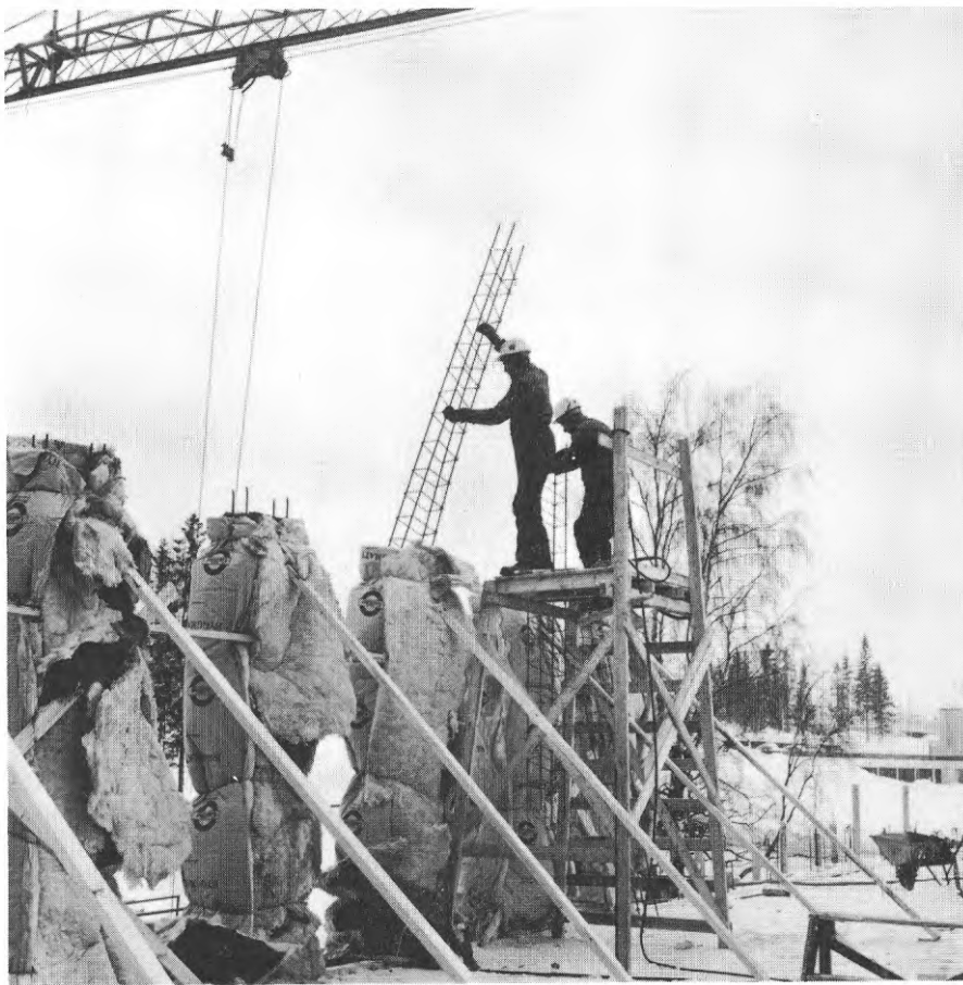
FIG. 20. Noggrann isolering av pelare och balkar vintertid krävs för att behålla betongens egenvärme.
