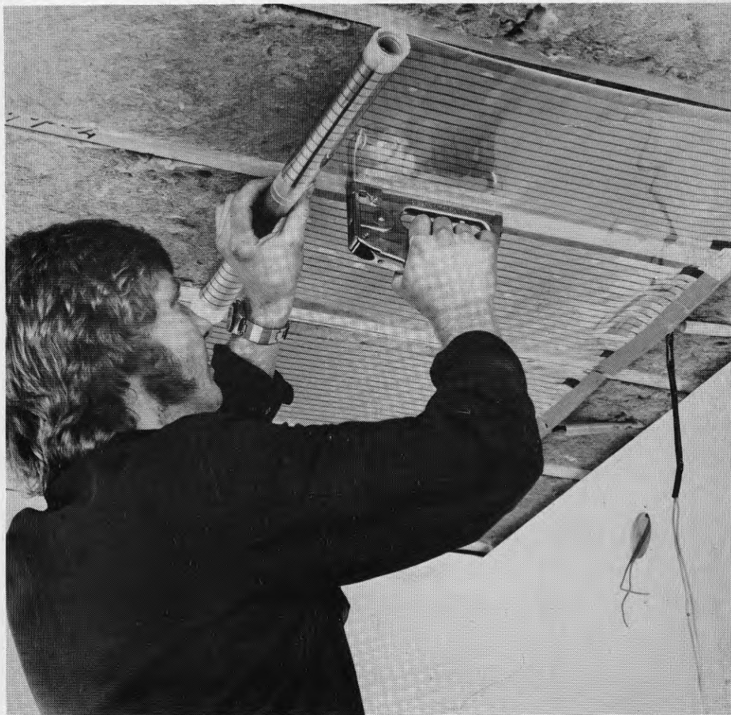
FIG 2a Montering av takvärmefolier.
