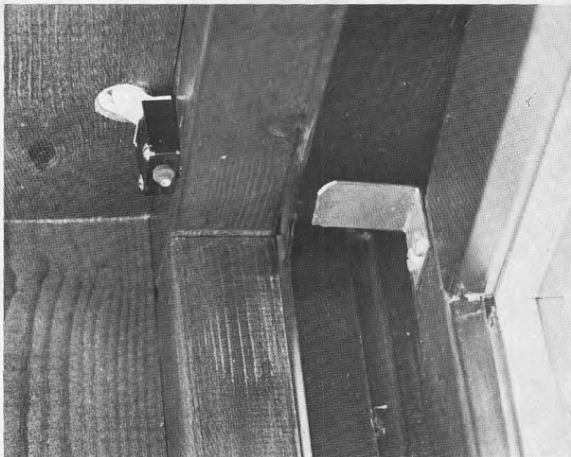
Microbrytare mellan båge och karm styr ström till radiatorer - mäter tid för fönsteröppning.
