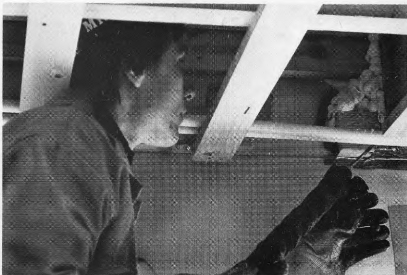
FIGUR 2.4.7 SPRUTNING MED FOGSKUM KRING GOLVBJÄLKAR
