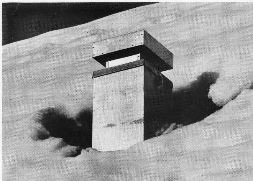
FIGUR 2.4.18 och .19. FOTON AV HUSTAK UTAN OCH MED FTX-AGGREGAT. FEBRUARI 1979.
