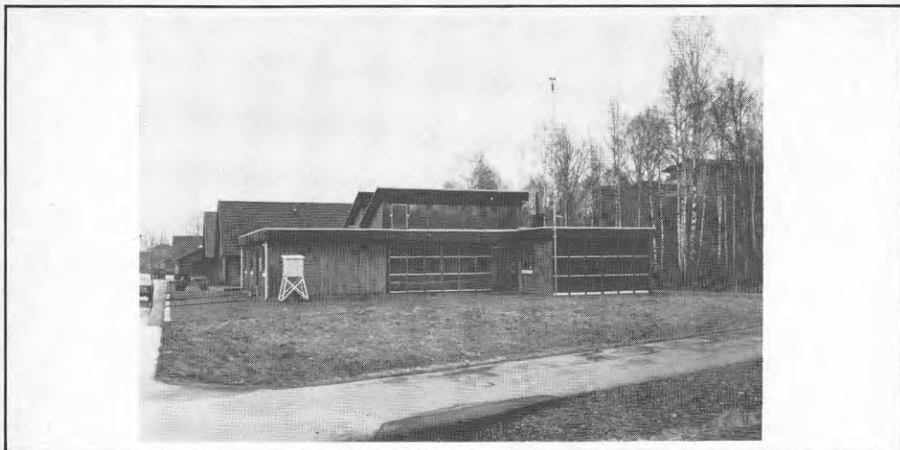
Fig 3.2 Experimenthusets södra fasad.
