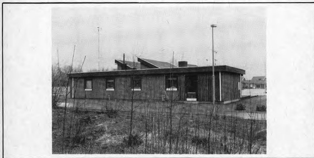
Fig 3.5 Experimenthusets östra fasad.
