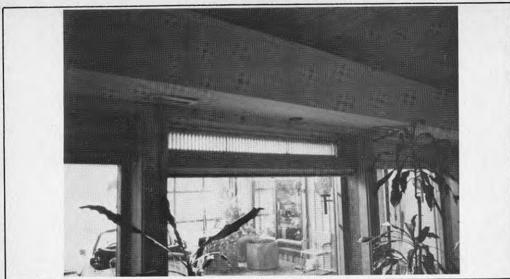
Fig 7.15 Vädringslucka i vardagsrummet.
