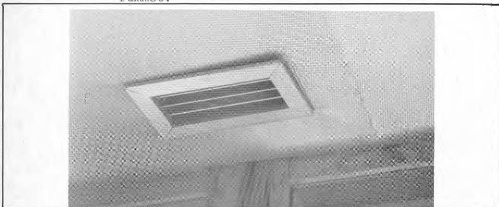
Fig 3.30 Tilluftsdon i vardagsrummet.
