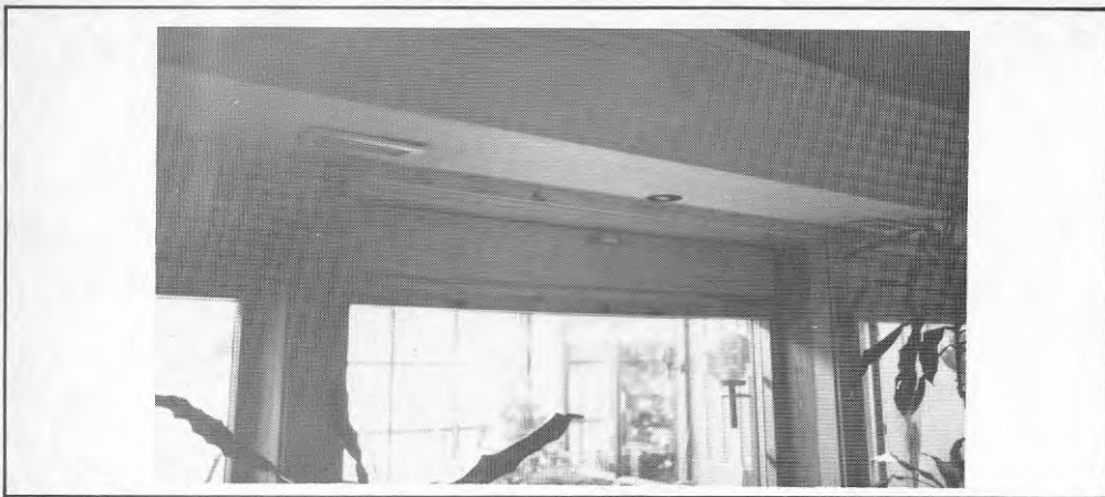
Fig 3.29 Placering av tilluftskanalen i vardagsrummet.
