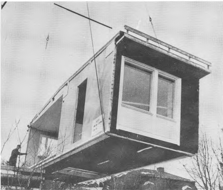
FIG. 16. Kranmontering av volymelement (sektionshus).
