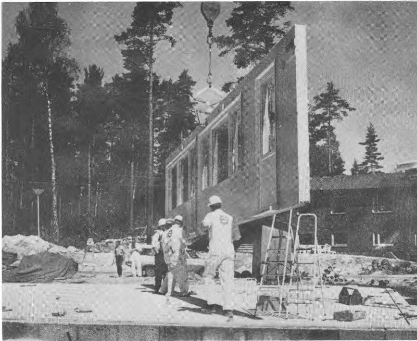
FIG. 15. Kranmontering av stora ytelement (storelement).
