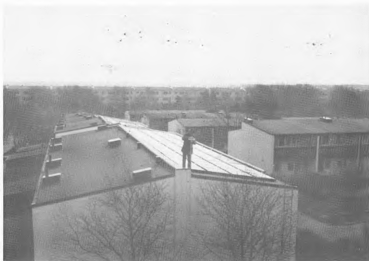
Radhusen med 2/3 av solfångarna riktade mot söder. På taket pågår rengöring av pyranometerglas och fyllning av torkgel i instrumentet.
