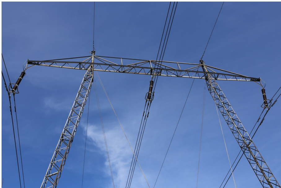
Figur 35. Fackverksstolpe
