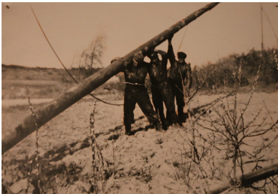
Figur 1. Resning av elstolpe, tidigt 1900-tal
