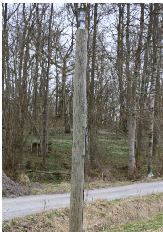
Figur 37. Gammal elstolpe som används för belysning
