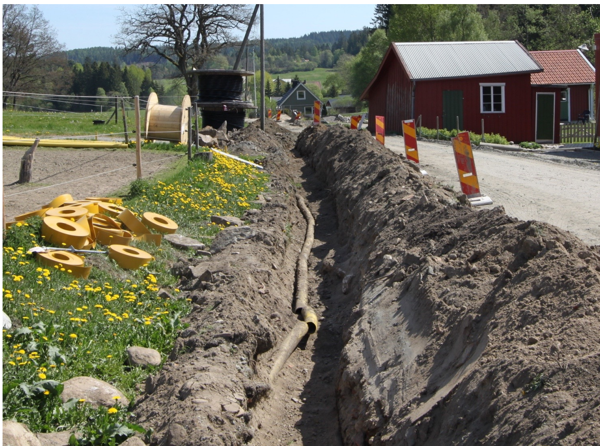
Figur 4. Nedgrävning av kabel.
