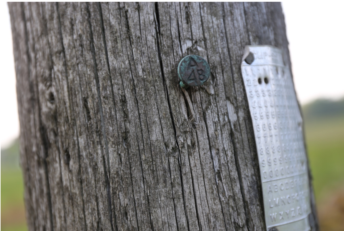
Figur 17. Årsmärkning på trästolpe, 1948.
