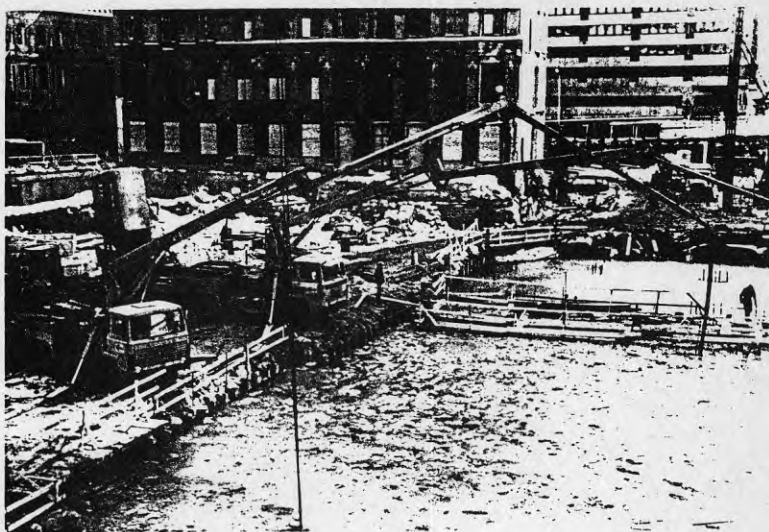
FIG 39. Vintrig undervattensgjutning. Kv Björnen, Stockholm
