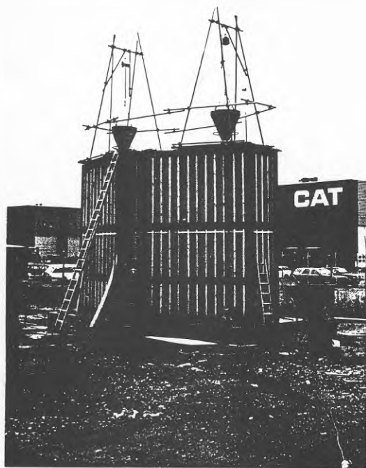
FIG 3. Form arrangerad för gjutning med två rör.
