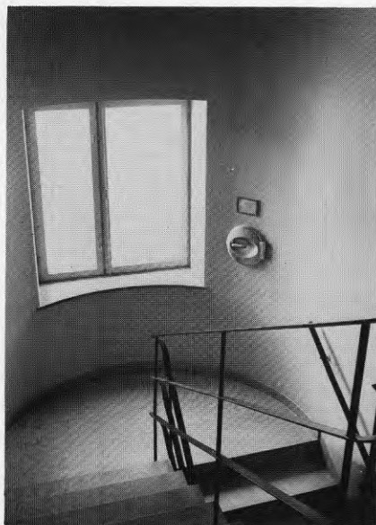
a. Många nedkast ligger med sopluckor i trappans halvplan Foto: Eva Eisenhauer
