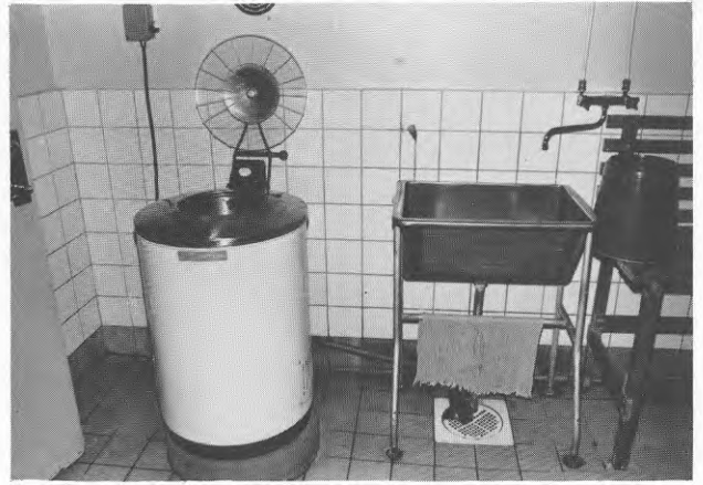
Tvättstuga från 1940-talet som renoverats.
