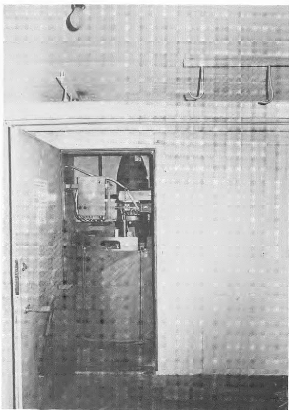
d. Nya eller ombyggda hus har ofta ett fullhögt soprum i bottenvåning eller källare
