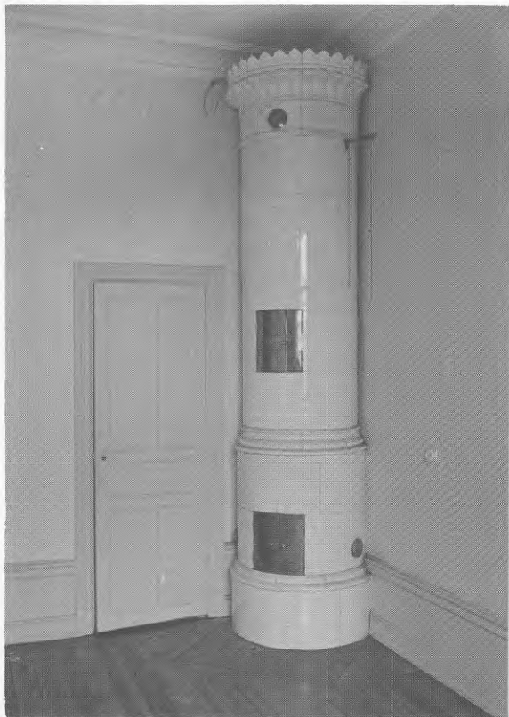
a. Relativt enkel kakelugn i ett sekelskifteshus. Obs anslutningarna till sockeln och det frilagda trägolvet.
