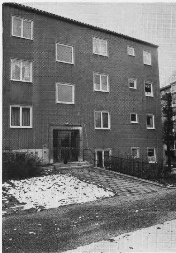
b. Utvändiga entrétrappor med ett par steg och ibland betydligt fler finns ofta vid hus byggda före 1960.
