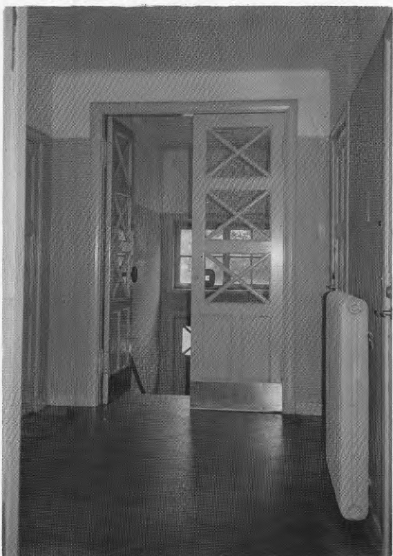
c. Invändiga entrétrappor är regel i äldre och halvgamla hus.
