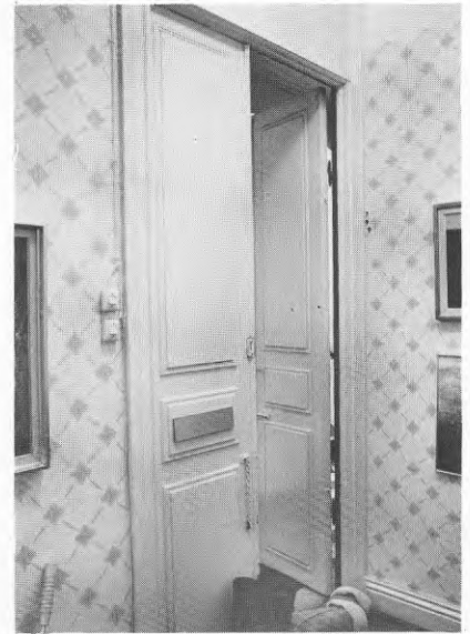
Lägenhetsdörrarna har klätts med 10 mm spånskiva på insidan, varigenom brandklass B15 uppnåtts.
