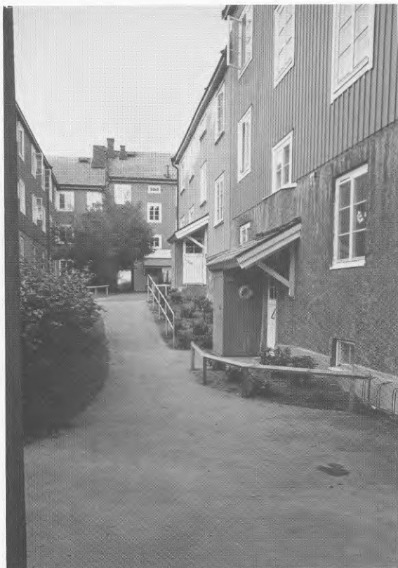
a. Fasadsoprum går att utföra på många hus. Där sopnedkast finns sneddras det genom väggen
