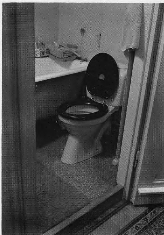
b. Typiskt 30-talsbadrum med smal dörr, hög tröskel, förhöjt golv och små mått invändigt.
