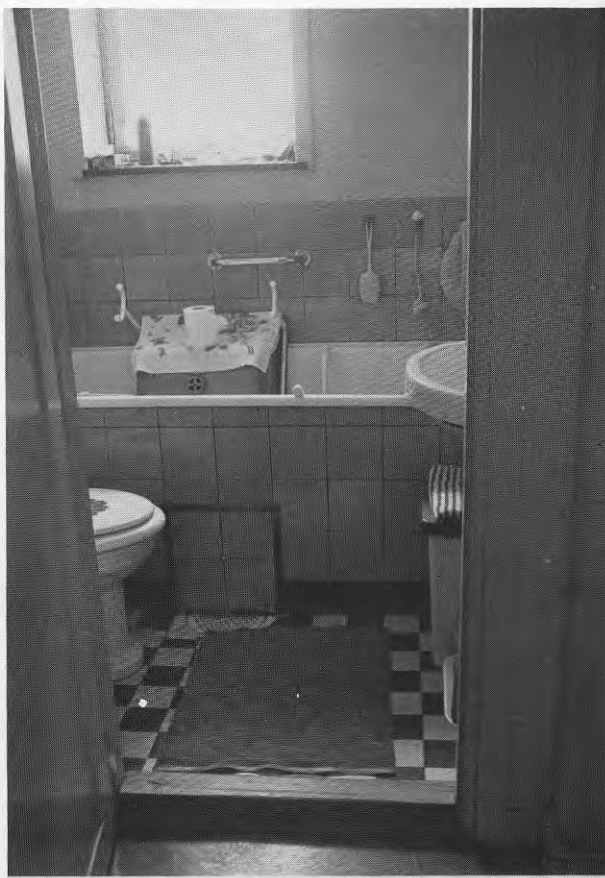
b. De halvgamla badrummen är oftast små, med badkaren inmurade eller på fötter. Obs de hållbara materialen och det ljusa läget.
