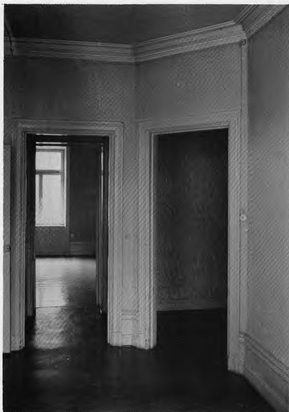
a. I gamla hus är passagerna mellan rummen ofta - inte alltid - breda nog. Hygienrumsdörrarna är smalare.
