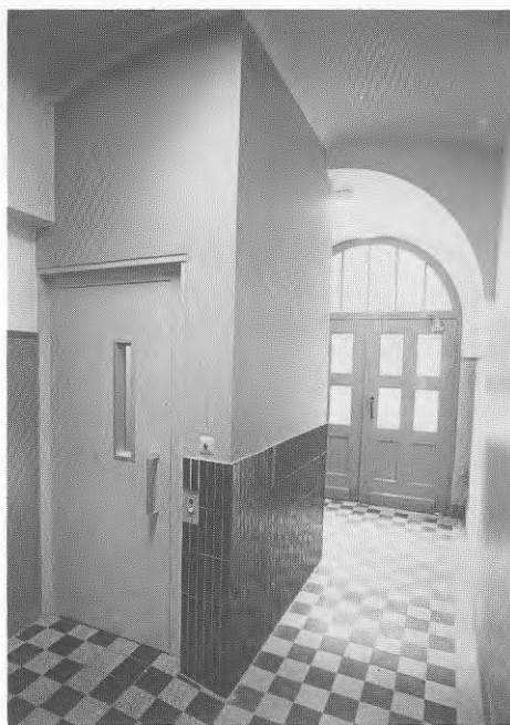
b. Hiss i trapploppet; minskad trappbredd. Det slutna schaktet gör anslutningen till bottenplanet onödigt hård.
