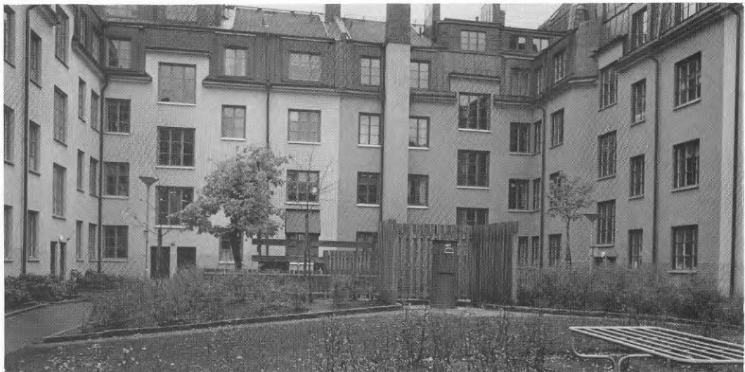
Figur 3.5:10 Nyinstallerat sopskruvsystem med inkast på gården.
