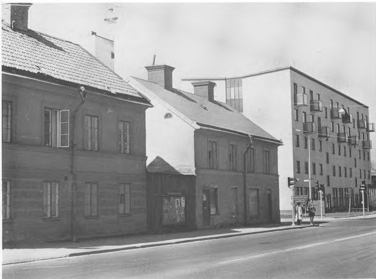
Figur 2.8:16 Tak från olika byggnadsperioder.
