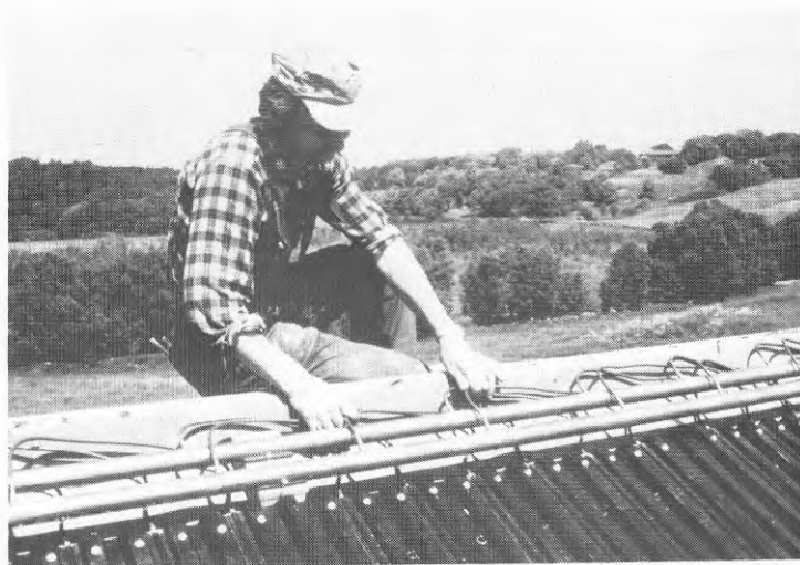
Figur 3.3 Övre delen av absorbatoren med samlingsrör
