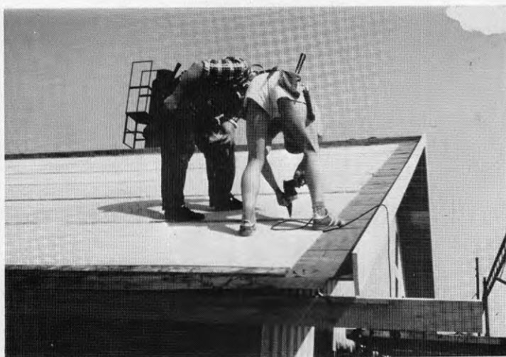
Figur 3.1 Montering av isoleringsskivor och plywoodremсор på takpappen.
