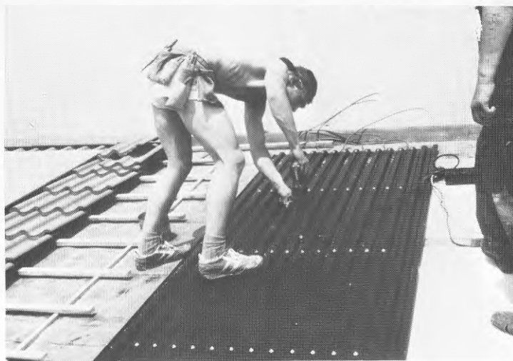
Figur 3.2 Montering av solfångare
