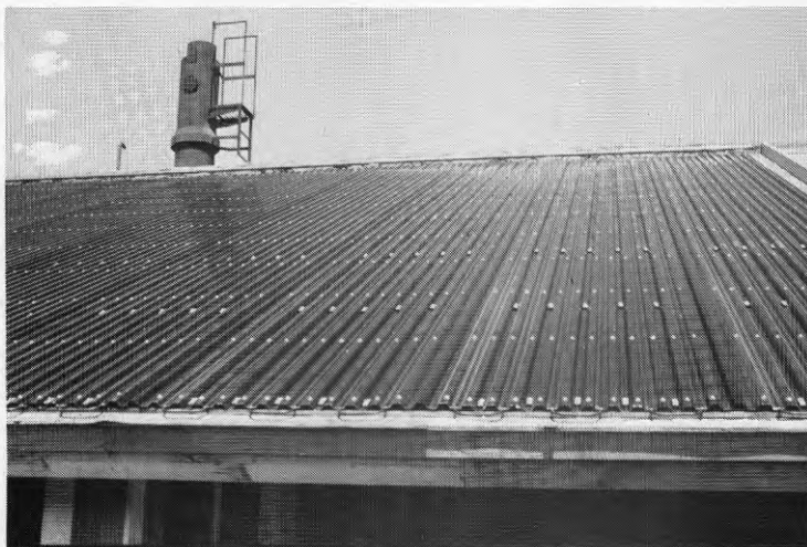
Figur 3.5 Färdigmonterad absorbator
