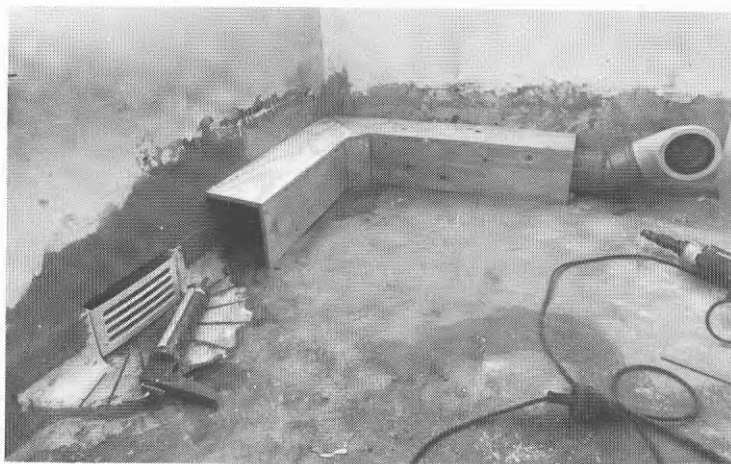
Figur 14. Väggbrunnen under montering. Avloppet från toaletten dras i en låda rakt ut till avloppsstammen.
