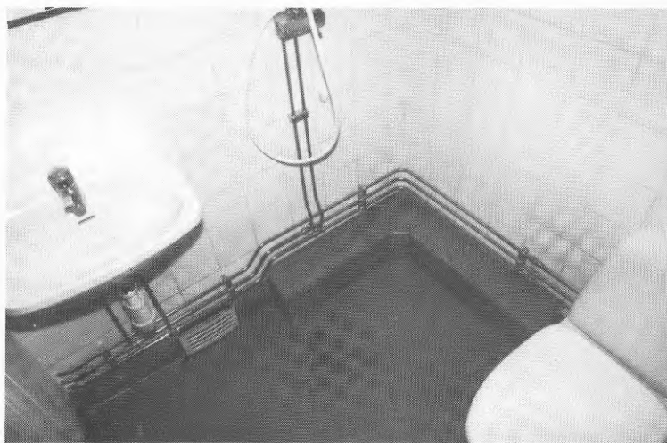
Figur 15. Färdigt duschrum i Inedal. Väggbrunnen sitter under tvättstället.
