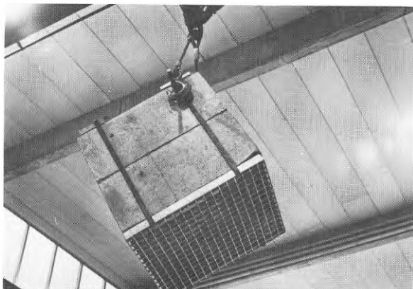
FIG. 7. Betonglåda med botten av utbytbar gallerdurk.
