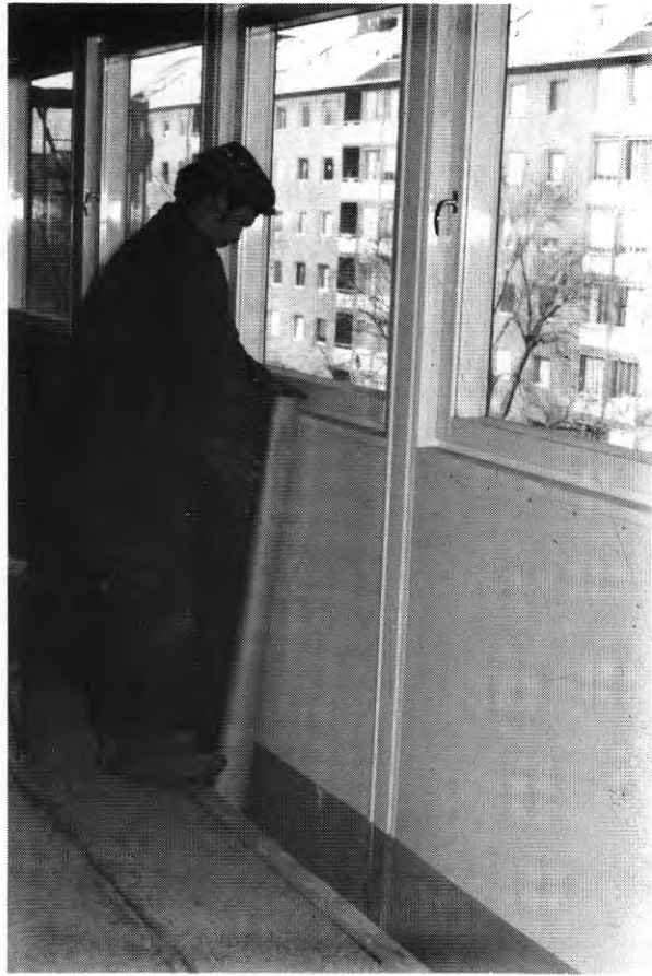
FIG. 60. Täckning av fasad med papper
