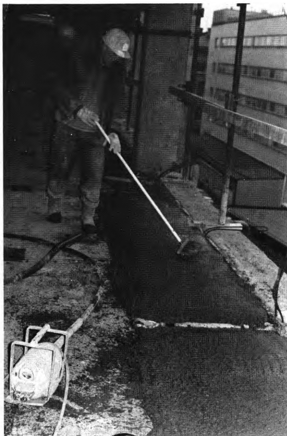
FIG. 57. Kvastning av fog
