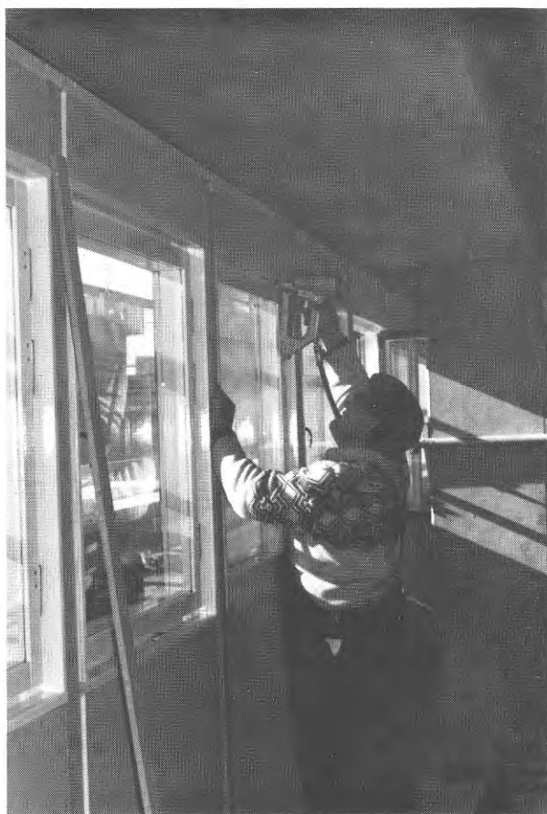
FIG. 87. Montering av täcklist av spånskiva över vertikalfog
