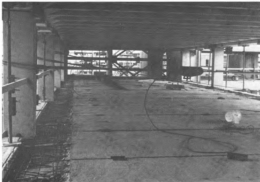
FIG. 38. Justering av lodavvikelse hos pelare med hjälp av tirlfortalja
