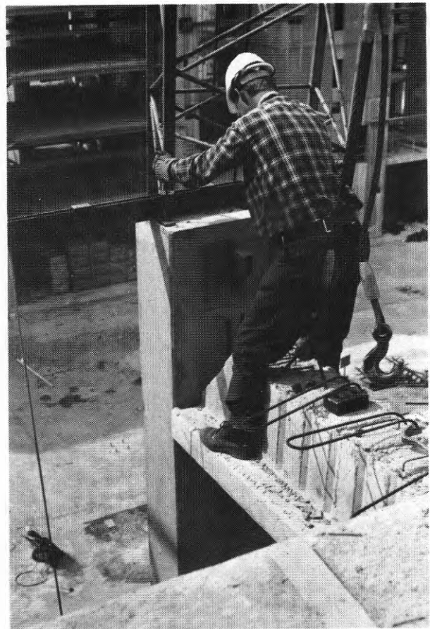
FIG. 12. Inpassning av balk
