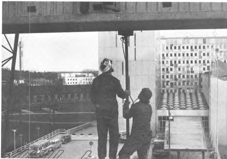
FIG. 14. Stämpning av balk
