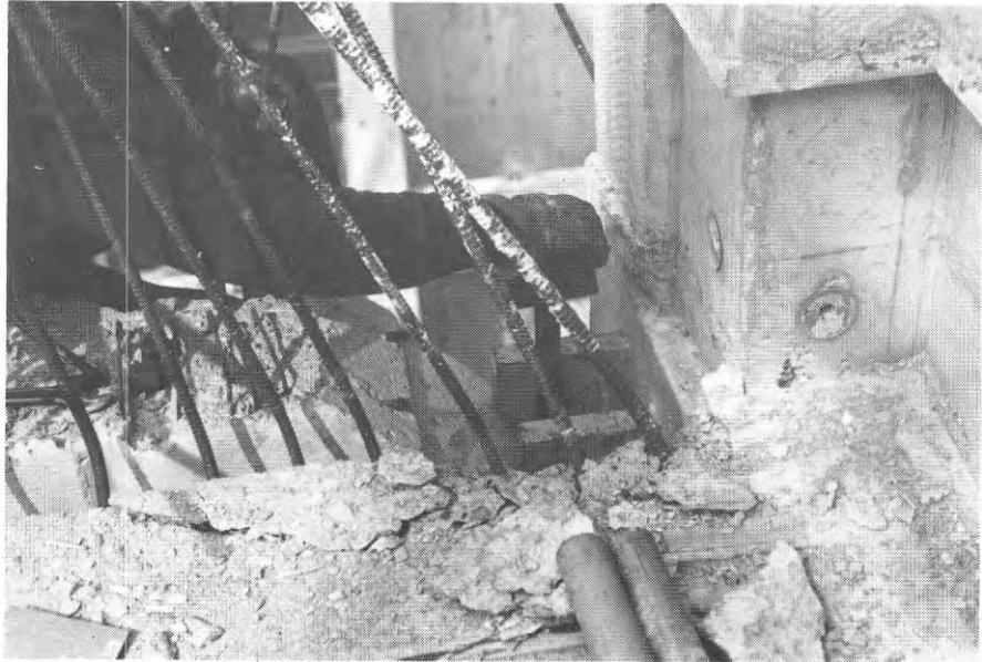
FIG. 13. Förankringsbricka (ok) monteras
