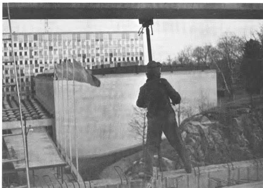
FIG. 31. Justering av balks horisontalläge (tvärs balken)
