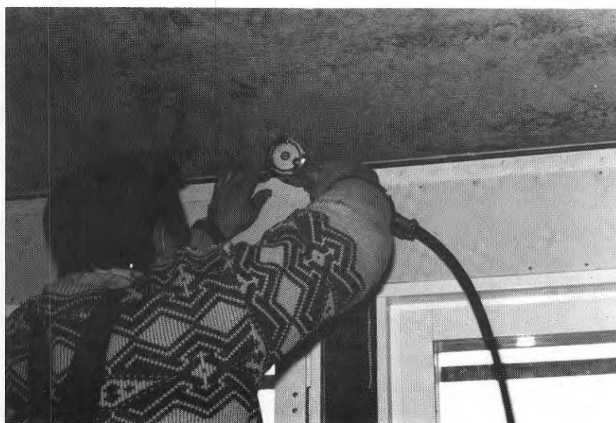
FIG. 85. Montering av täcklist vid fasadens överkant
