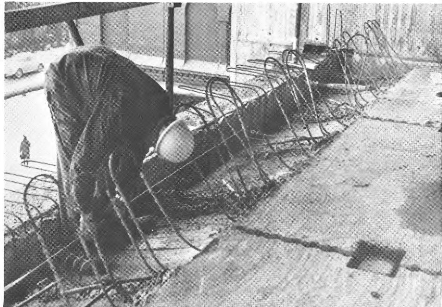
FIG. 52. Armering av K-ände
