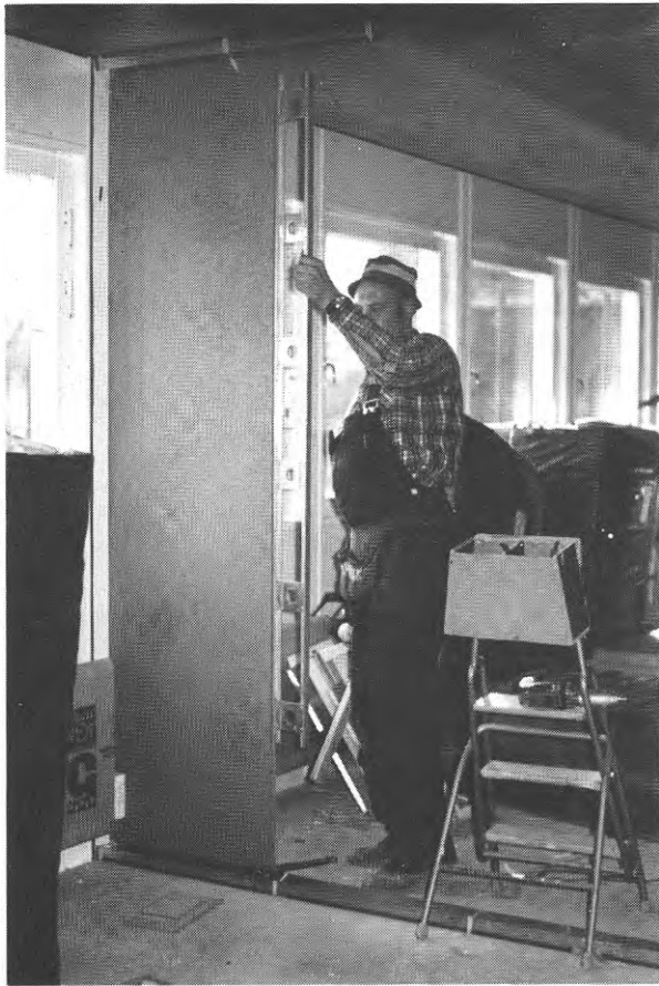
FIG. 104. Montering av första väggskivan mot fasad
