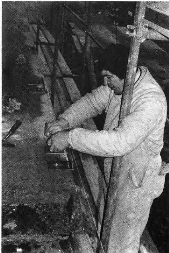
FIG. 71. Montering av horisontala fästjärn
