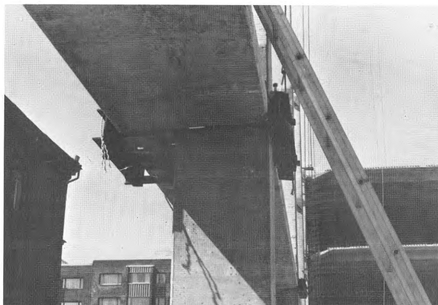
FIG. 34. Montering av dubbelklammer, klammer på plats
