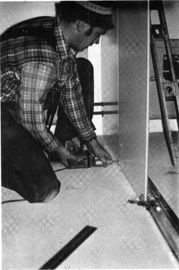
FIG. 106. Montering av väggskiva
