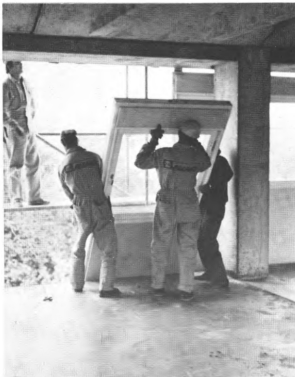
FIG. 72. Resning av fasadelement
