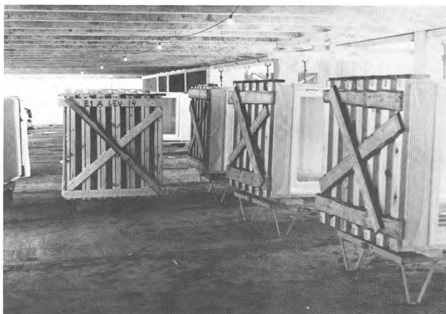
FIG. 69. Häckar med fasadelement
