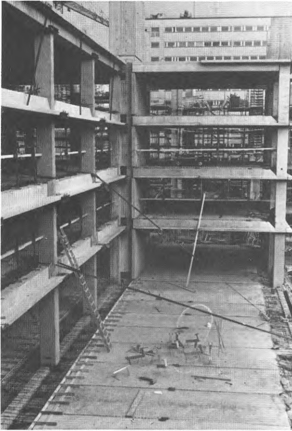
FIG. 35. Korrigerig av stomme med wirar och tirkfor- block
