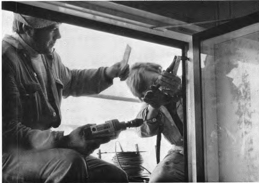
FIG. 81. Montering av fasadplåt mellan fönster
