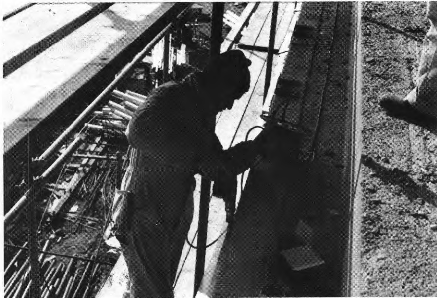
FIG. 74. Infästning av fasadelements överkant
