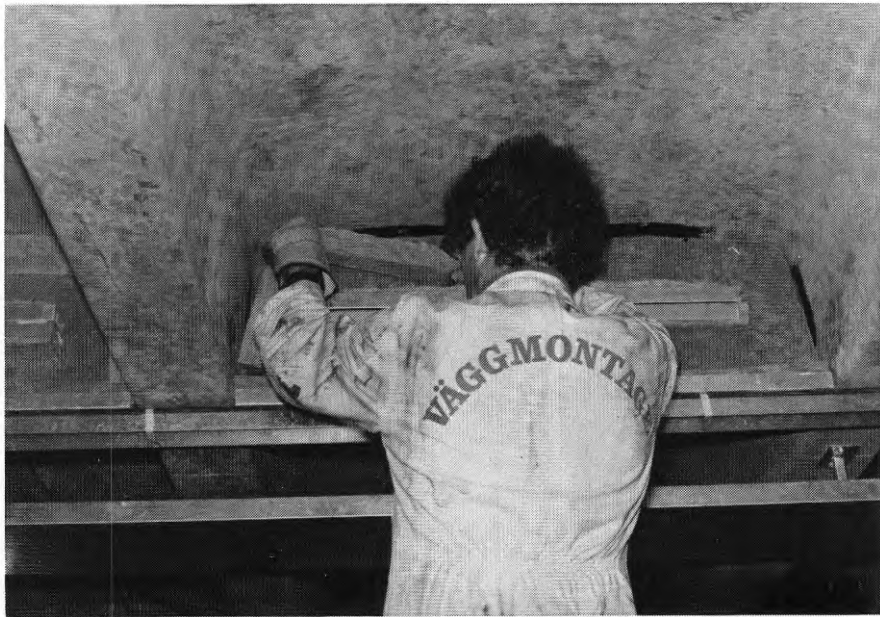
FIG. 98. Montering av isolering, sedan skivorna på en sida monterats
