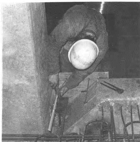
FIG. 50. Formsättning. Distanshållare av trä
