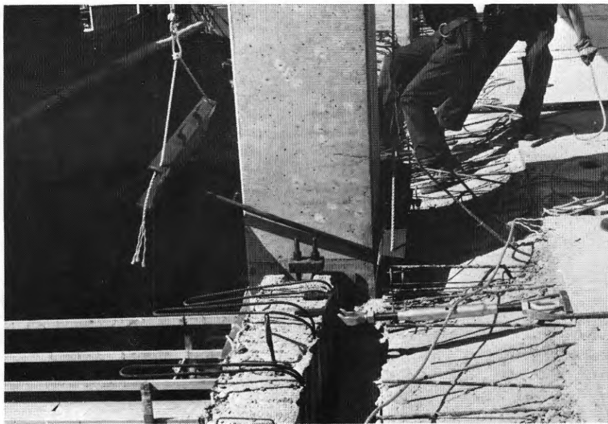
FIG. 32. Montering av dubbelklammer, hissning
