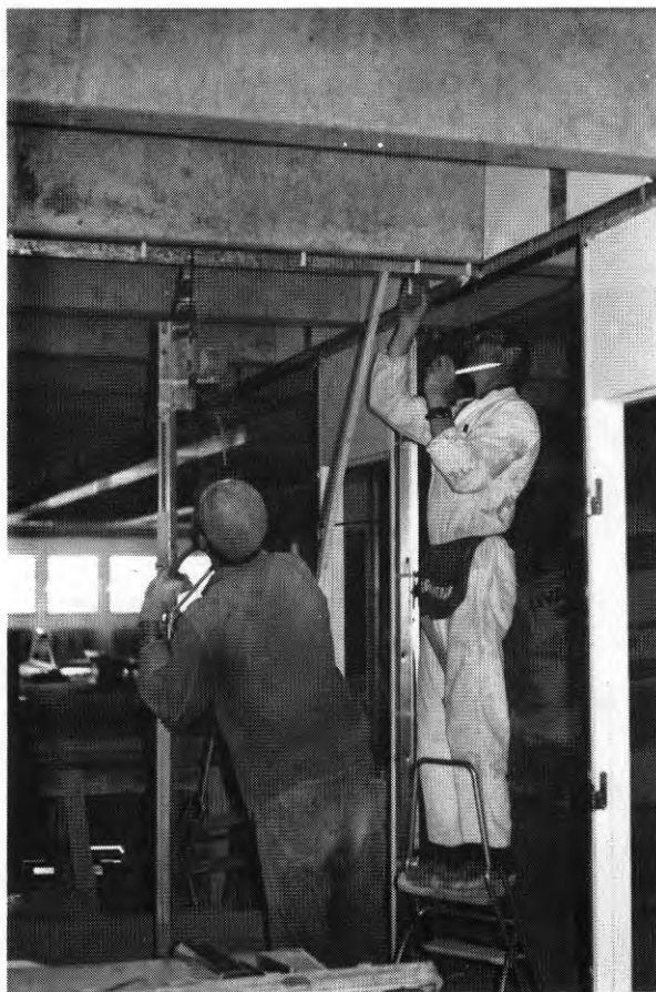
FIG. 102. Montering av stålprofil på kassettbalk
