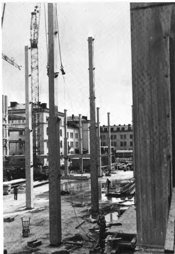
FIG. 8. Demontering av lyftdon för pelare
