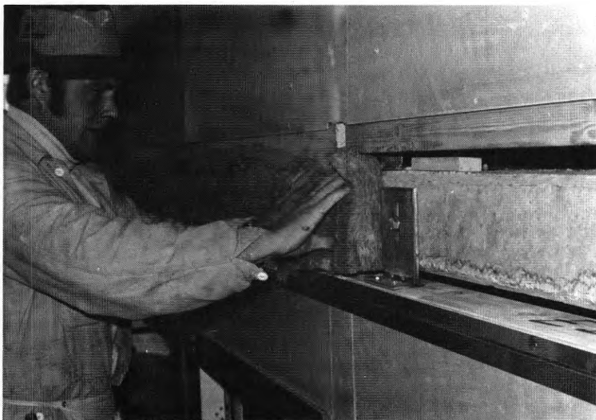
FIG. 77. Isolering av horisontalfog med mineralull mot balkkant
