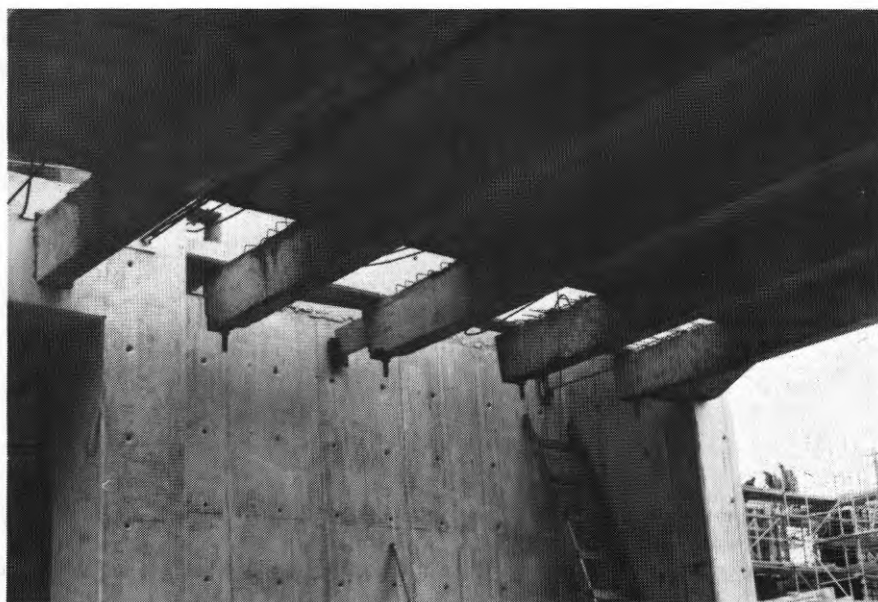
FIG. 26. Bjälklagsplattor, bulthängda i platsgjuten konstruktion
