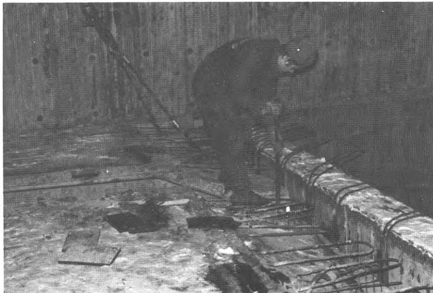
FIG. 20. Injustering av bjälklagsplatta
