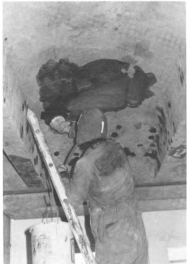
FIG. 45. Filtning av gjutblåsor
