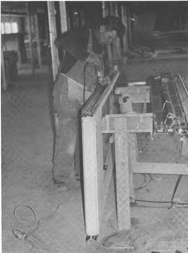
FIG. 99. Montering av stålregel på karm
