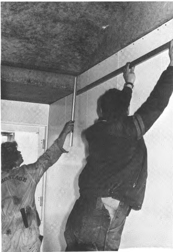
FIG. 108. Uppmätning av tavel- list
