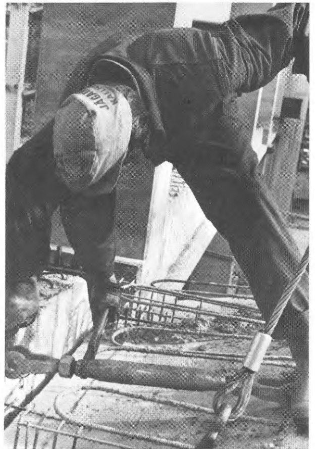
FIG. 36. Montering av vantstag
