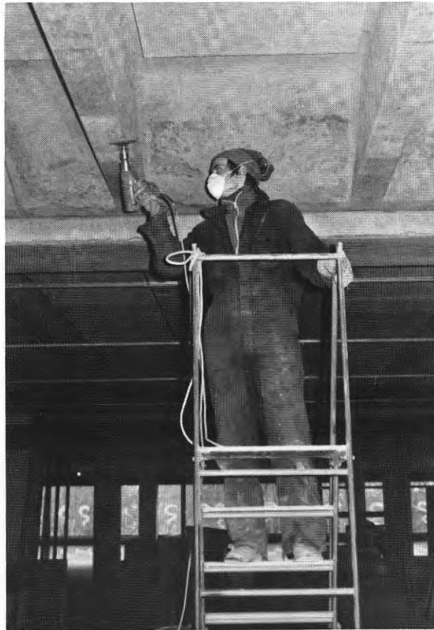
FIG. 46. Bortslipning av pallmärken
