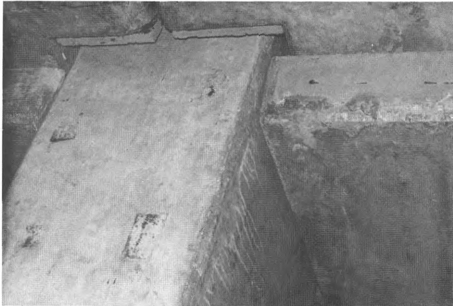
FIG. 47. Utlagning av fog mellan pelare och bjälklagsplattor
