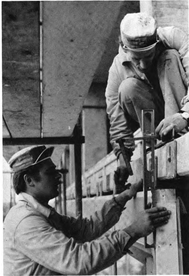
FIG. 73. Inmätning av fasadelements överkant
