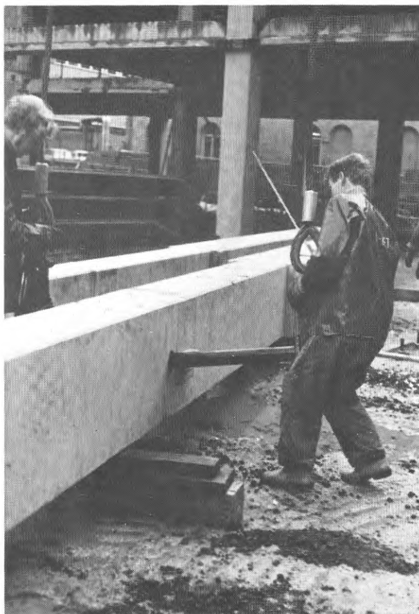
FIG. 6. Lyftdon för pelare
