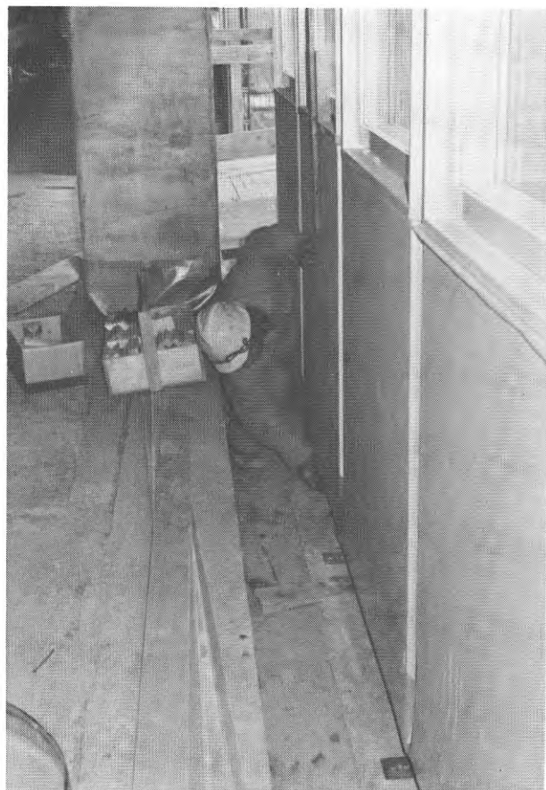
FIG. 75. Justering av fasadelement i höjddled
