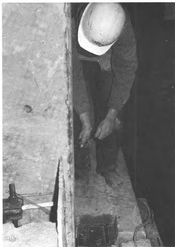
FIG. 49. Formsättning. Förankring av form
