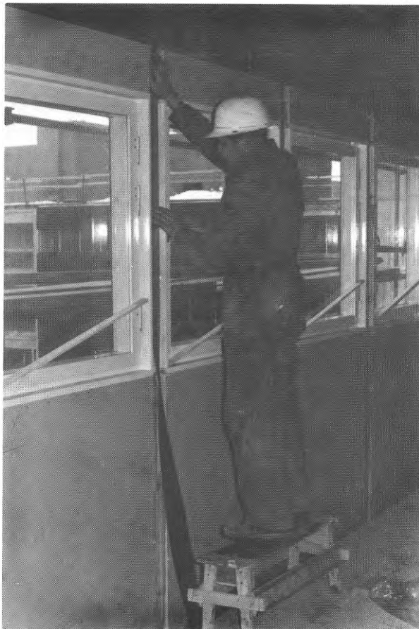
FIG. 82. Fogtätning med neopren
