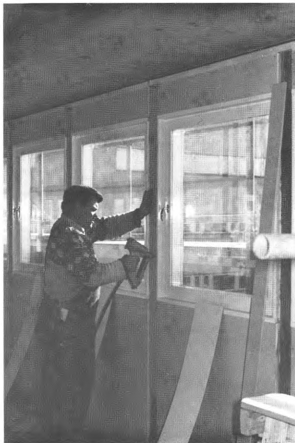
FIG. 86. Montering av täcklist i fog mellan element
