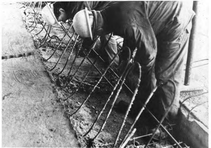
FIG. 53. Armering av K-ände
