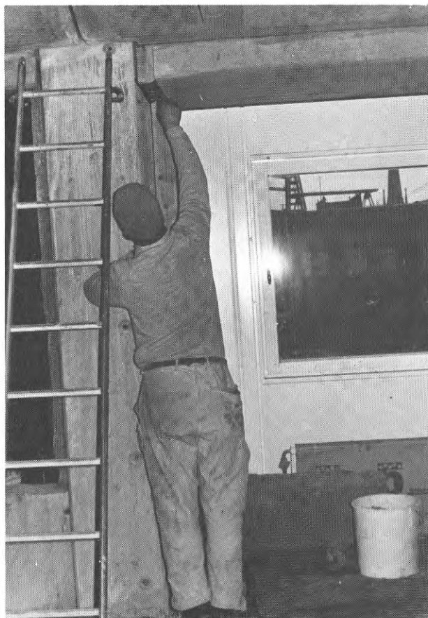
FIG. 41. Utlagning av fog mellan pelare och balk
