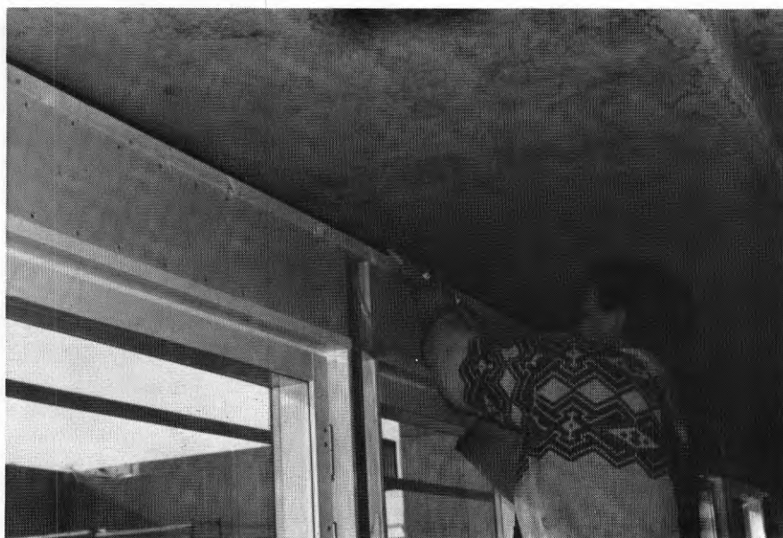
FIG. 84. Tätning med fogmassa mellan gummiprofil och tak
