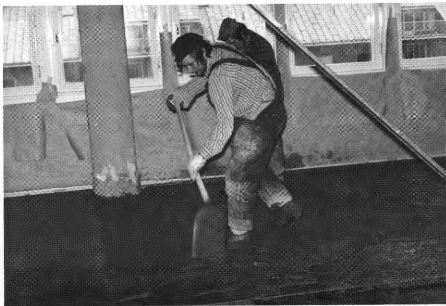
FIG. 63. Fördelning av bruk
