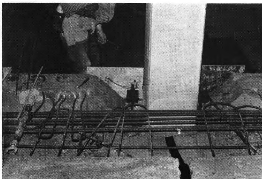
FIG. 48. Formsättning av anslutningen balk - pelare - balk
