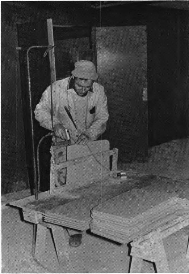
FIG. 96. Montering av tätning- list av gummi på specialelementskiva
