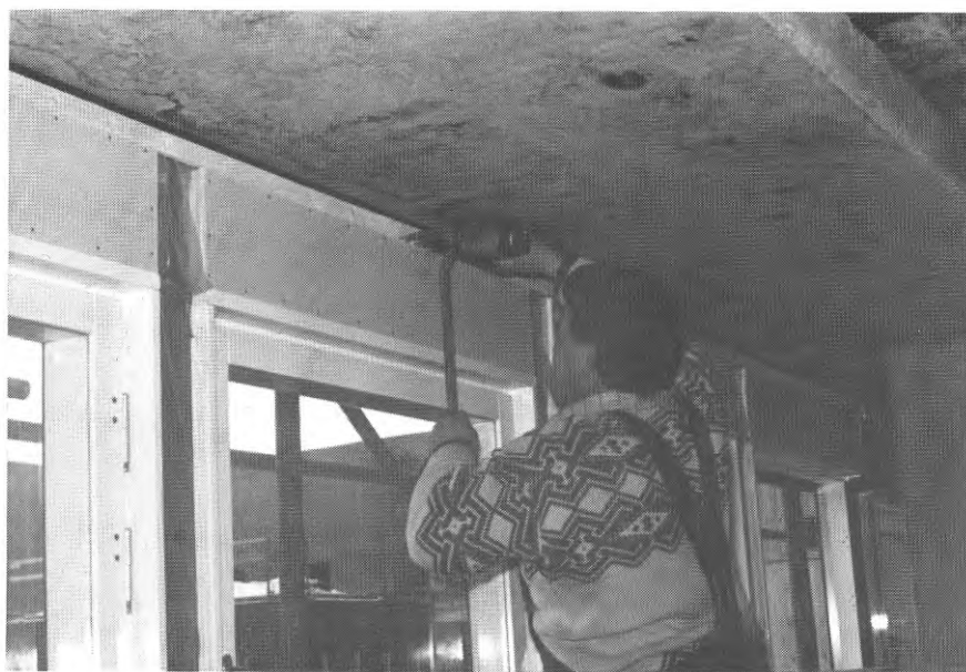
FIG. 83. Montering av tätningslist mot tak
