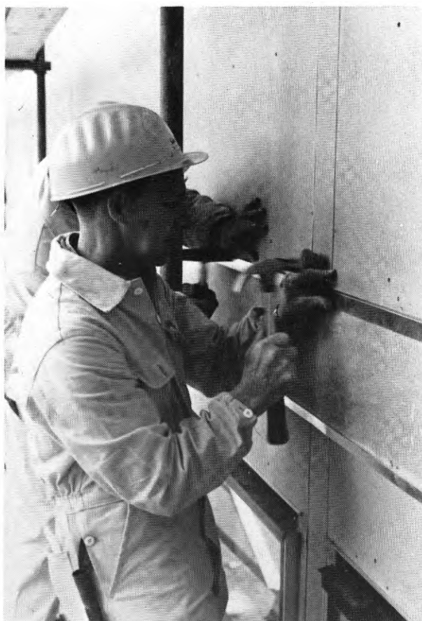
FIG. 78. Montering av Al-list i horisontalfogs överkant
