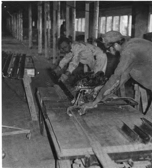
FIG. 101. Arbetsbänk för tillkapning av profiler m m
