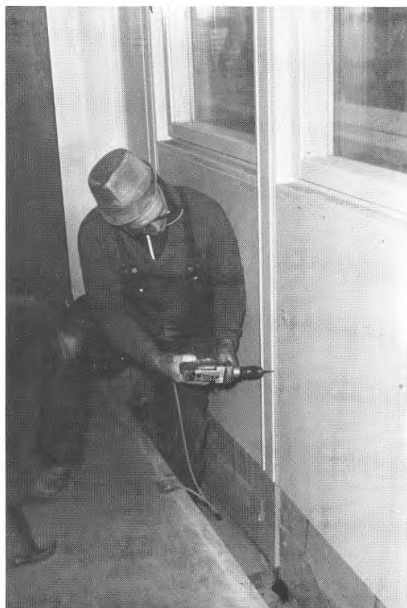
FIG. 88. Montering av Al-profil mellan fasadelement
