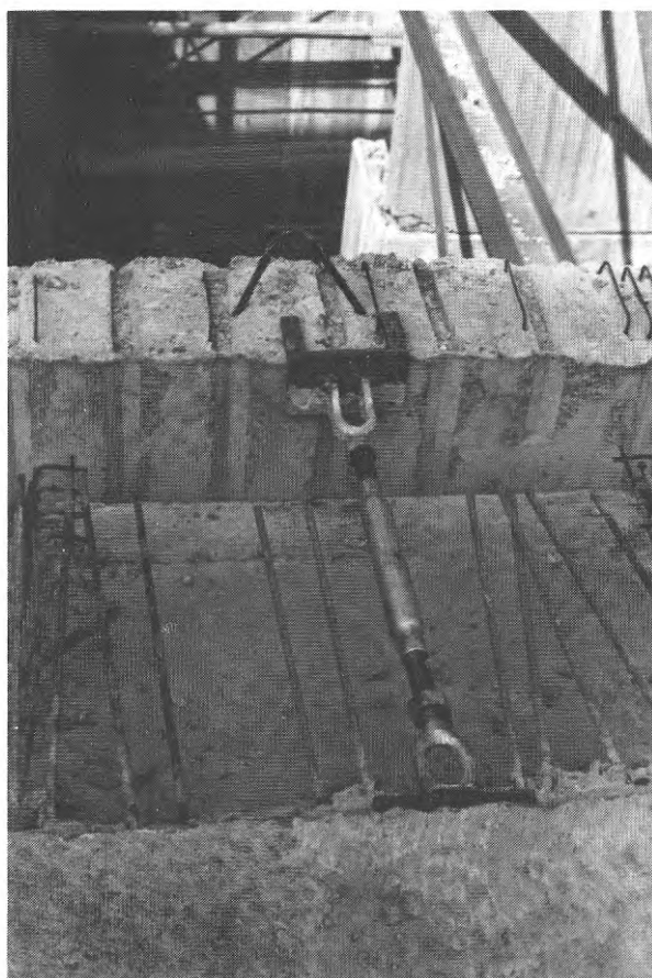
FIG. 21. Stag mellan balk och bjälklagsplatta
