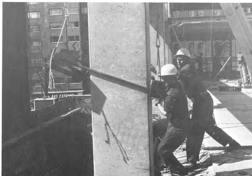
FIG. 33. Montering av dubbelklammer, hissning
