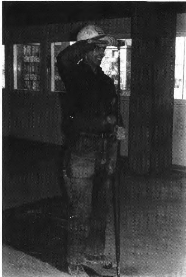
FIG. 61. Punktning för övergolv
