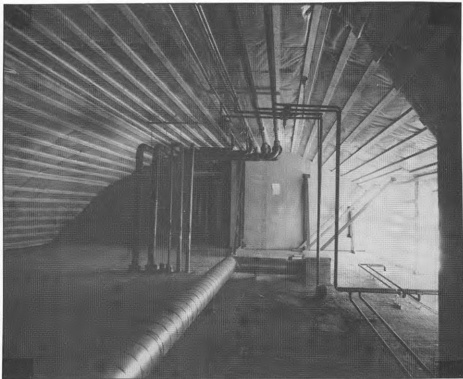
BILD 7. Skarpnäckstaden, Stockholm. Servicevänlig vind.
