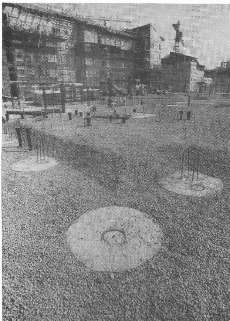
BILD 11. Skarpnäckstaden, Stockholm. Pågående grundarbeten - ingen kulvert och få gropar.
