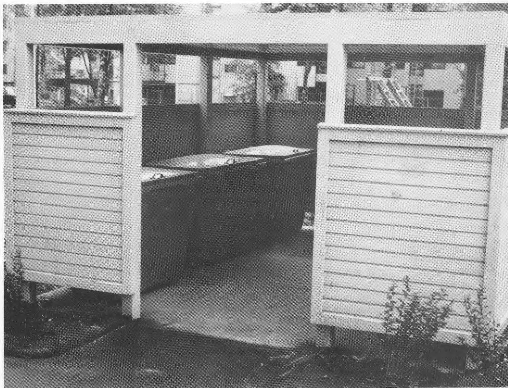
BILD 10. Byggnad för separering av sopor i bostadsområde i Helsingfors.
