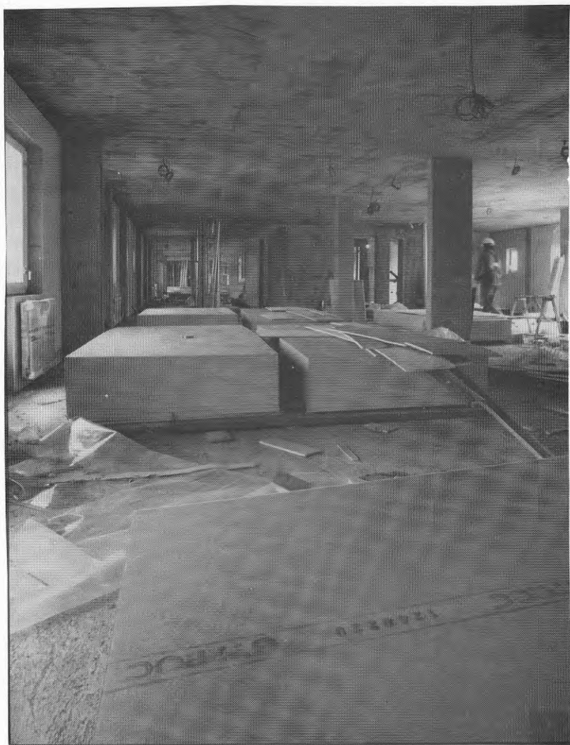
BILD 15. Skarpnäckstaden, Stockholm. Horisontell hantering av skivmaterial och komponenter.
