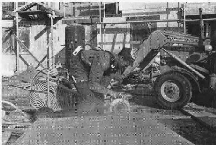
Figur 1. Personburen provtagning vid sågning i eternitplattor
