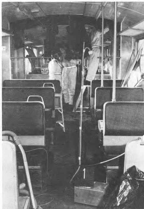
Figur 2. Stationär provtagning vid asbestrivning
