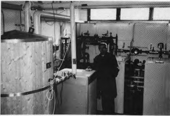
FIG.2.2 VVB(B1) och värmepump VP3 i förgrunden och VP1 och VP2 i bakgrunden
