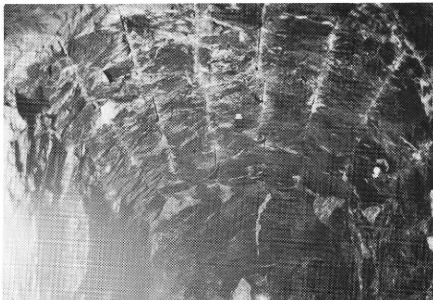
Fig. 10 Tunnelkontur efter slätsprängning.
