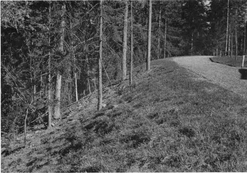
Fig. 11. Anpassning till befintlig mark och vegetation har skett i plan men inte i höjd. En lång och hög slänt blev följden. De flesta av granarna i släntuppfyllnaden kommer inte att klara sig.
