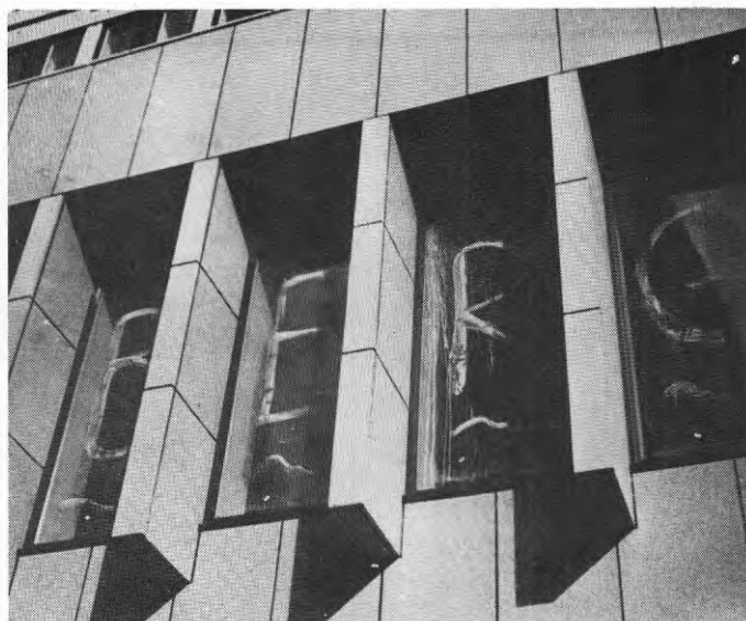
FIG. 8.11c Utskjutande väggpartier mellan fönster kan endast ge skugga vid snett infallande sol och ger ringa solskyddsverkan.
