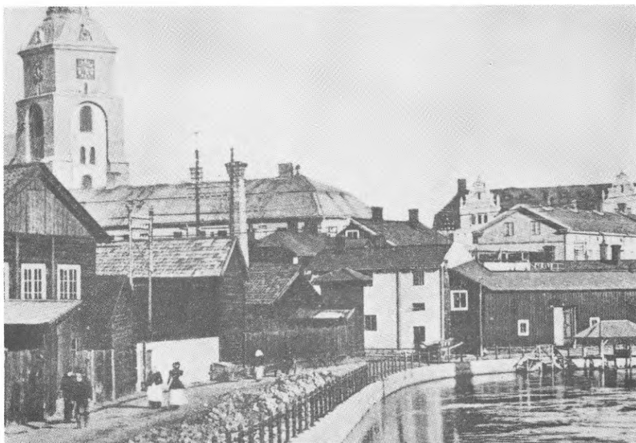
FALUN. Östra Hamngatan vid Faluån. I fonden Kristine kyrka. Efter äldre foto från omkring år 1905. (I: Ett urval bilder över gamla Falun.)
