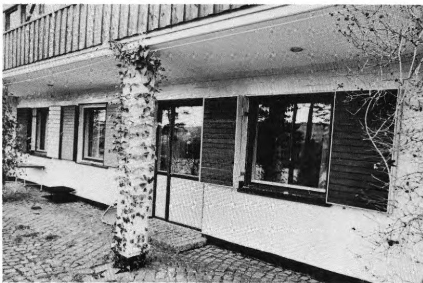
FIG. 5 Isolerande fönsterluckor. Prototyper monterade på villabyggnad i Skövde.
