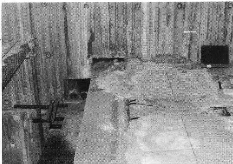
FIG. 72 Linje för fasadmontering Line for erection of facade
