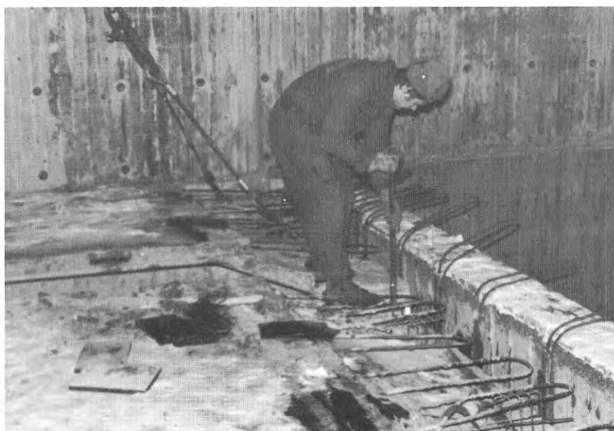
FIG. 54 Injustering av bjälklagsplatta
