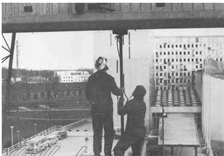
FIG. 38 Stämning av balk Propping of beam
