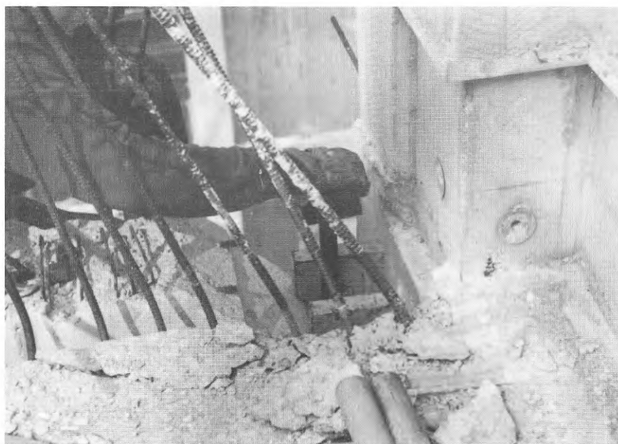
FIG. 37 Förankringsbricka (ok) monteras Placing of anchorage washer (yoke)
