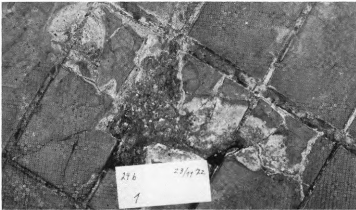
Bild 10. Extrem kemisk-termisk belastning. Klinker skadades genom frätande lösning med hög temperatur.
