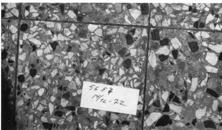
Bild 57. Marmormosaikgolv, ej trafikerad yta. Vål bibehållen fastän ej underhållen yta.
