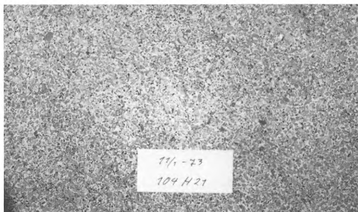
Bild 59. Terrazzogolv. Väl bibehållen och med golvvårdsmedel underhållen yta.
