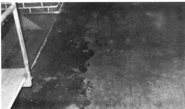
Bild 49. Klar epoxi i lasthall, mindre än 1 mm, 3 år, rester kvar på ej trafikerade ställen.
