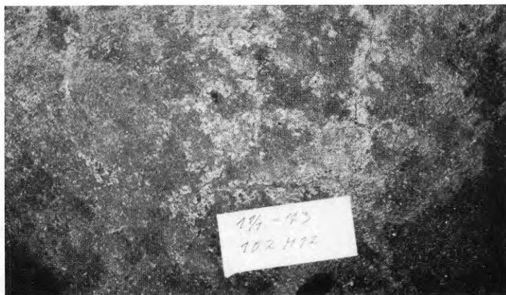
Bild 39. Fluat, 13 år, synliga spår av ytbehandling kvar på hårdast trafikerat garagegolv.
