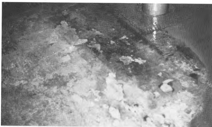
Bild 30. Polyuretan, mindre än 1 mm tjock, 3 månader gammal, applicerad på golv efter enbart kallavfettning.
