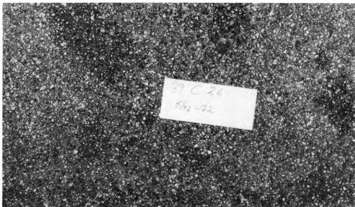
Bild 55. Epoxitjära, 4 mm tjock, 0,5 år, med kvartssand som halkskydd i garageuppfart.
