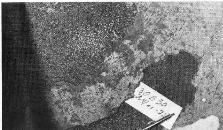
Bild 32. Pigmenterad epoxi, ej förankrad i golvet.
