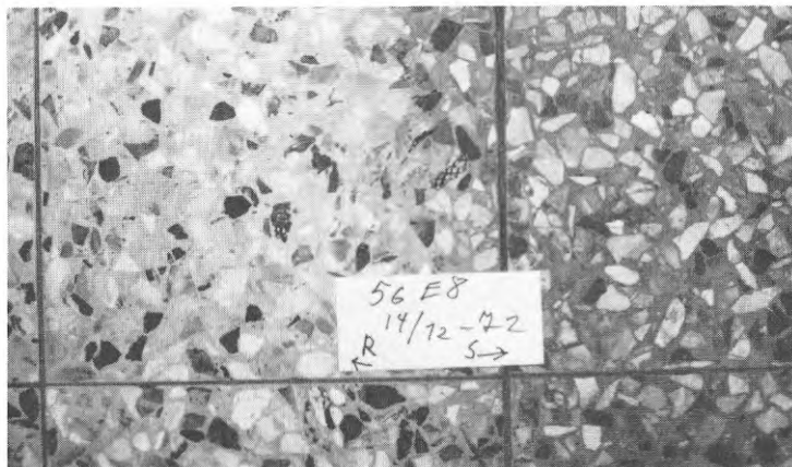
Bild 58. Samma golv som bild 57. Gränsszon mellan trafikerad och ej trafikerad yta. Golvet är starkt missfärgat, fastän nyss grundligt rengjort.
