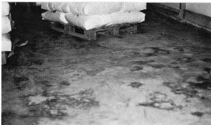
Bild 56. Polyuretan klar, mindre än 1 mm, 0,5 år gammal. Golvet hade dessförinnan varit behandlat med vinyl, som inte höll och slipades bort. Missfärgningarna är rester av vinyl.
