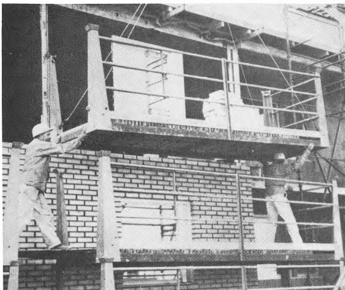
FIG. 11. Ställningsbockar, s.k. Aros-pallställning, som använts på arbetsplatsen i Bäckby. En ställningsenhet omfattar bottenram, hörnstolpar, ständare, räckerör och murartrall. Längd 4,5 m, bredd 1,5 m, höjd 1,3 m, vikt 450 kg och max. belastning 450 kg/m 2 .
