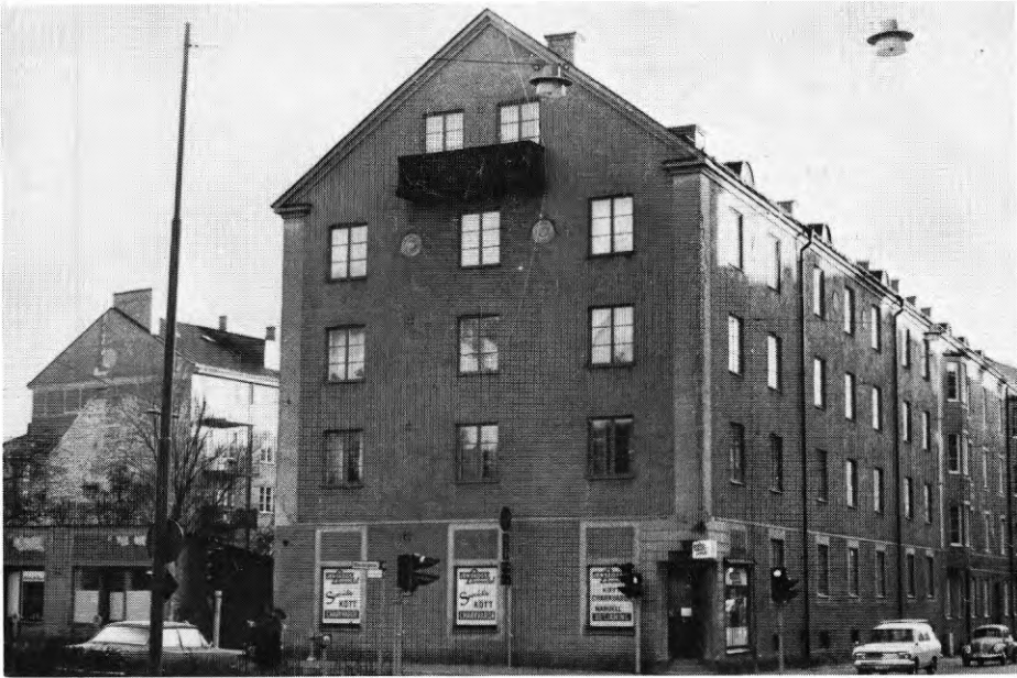
FIG. 7.2 Kv Dryckeshornet. Linköping 1971. Husen längs Drottninggatan - till höger - måste rivas om den planerade gatubreddningen skulle genomföras.
