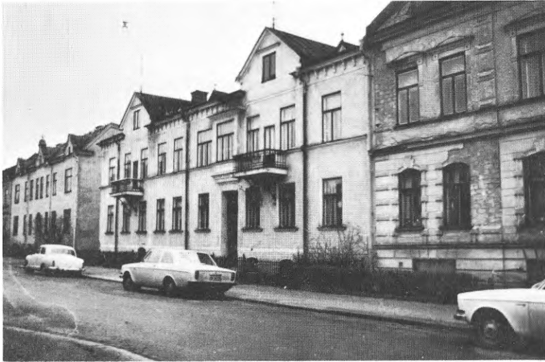
FIG. 5.9 Kv Tulpanen, Örebro 1971. Kvarteret omges av relativt lugna bostadsgator. Huset längst till höger, som ligger mot Vasatorget och city, är det enda som utsatts för direkt planpåverkan. Underhållet har dock efter-satts för samtliga fastigheter.
