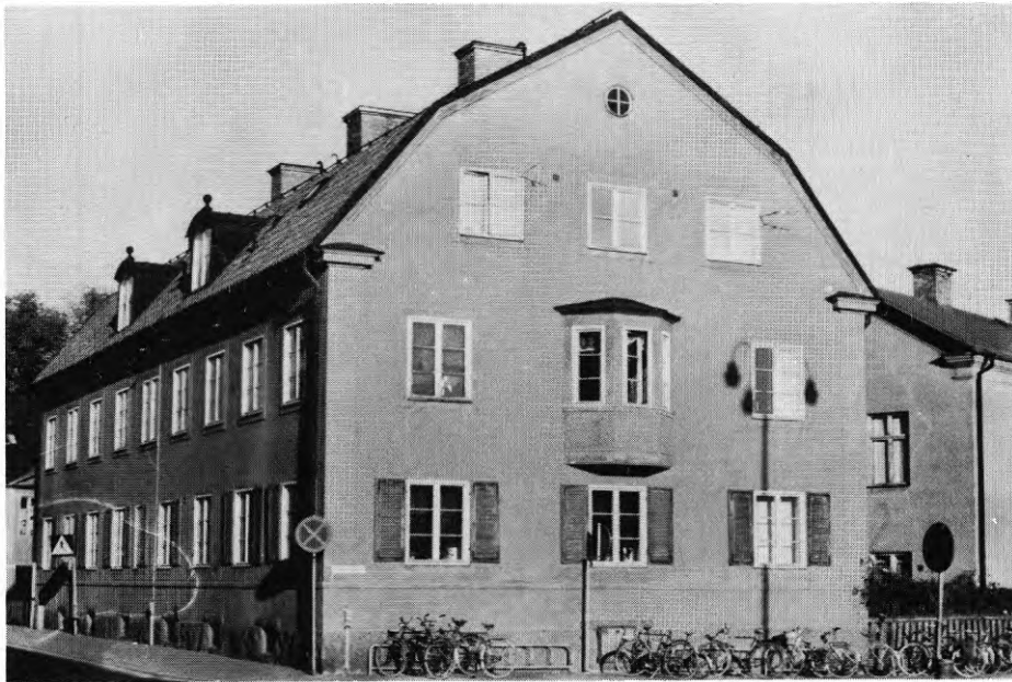
FIG. 7.4 Kv Ekonomen. Linköping 1971. Fem hus på en av de två stora tomterna utgör hem för gamla och ägs av en stiftelse.
