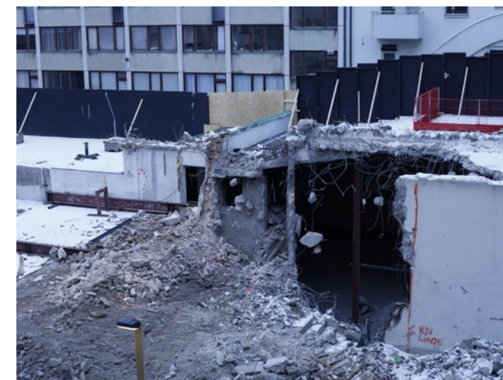
Rivning av byggnad
