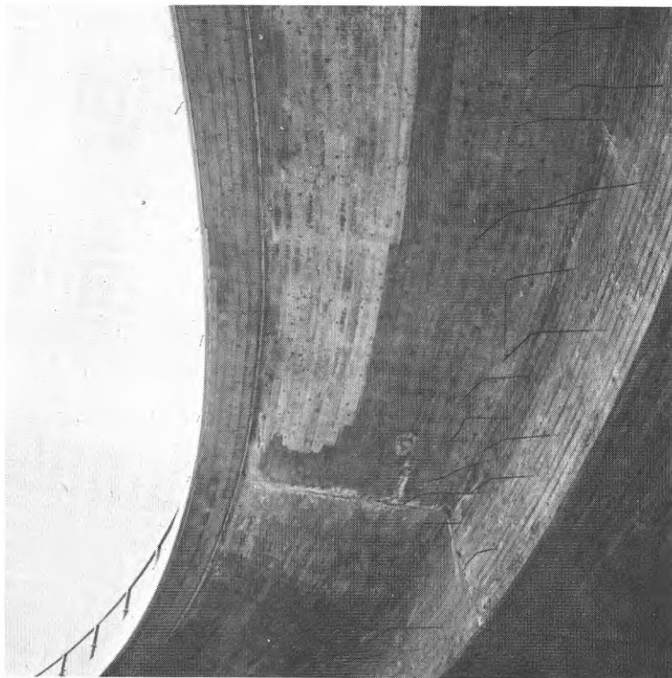
FIG. 92. Färgskillnader som orsakats av olikheter i formvirke.
