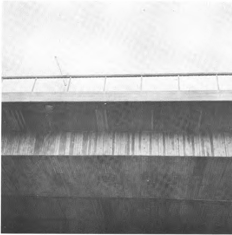
FIG. 91. Färgskillnader orsakade av bräder med olika fukthalt.
