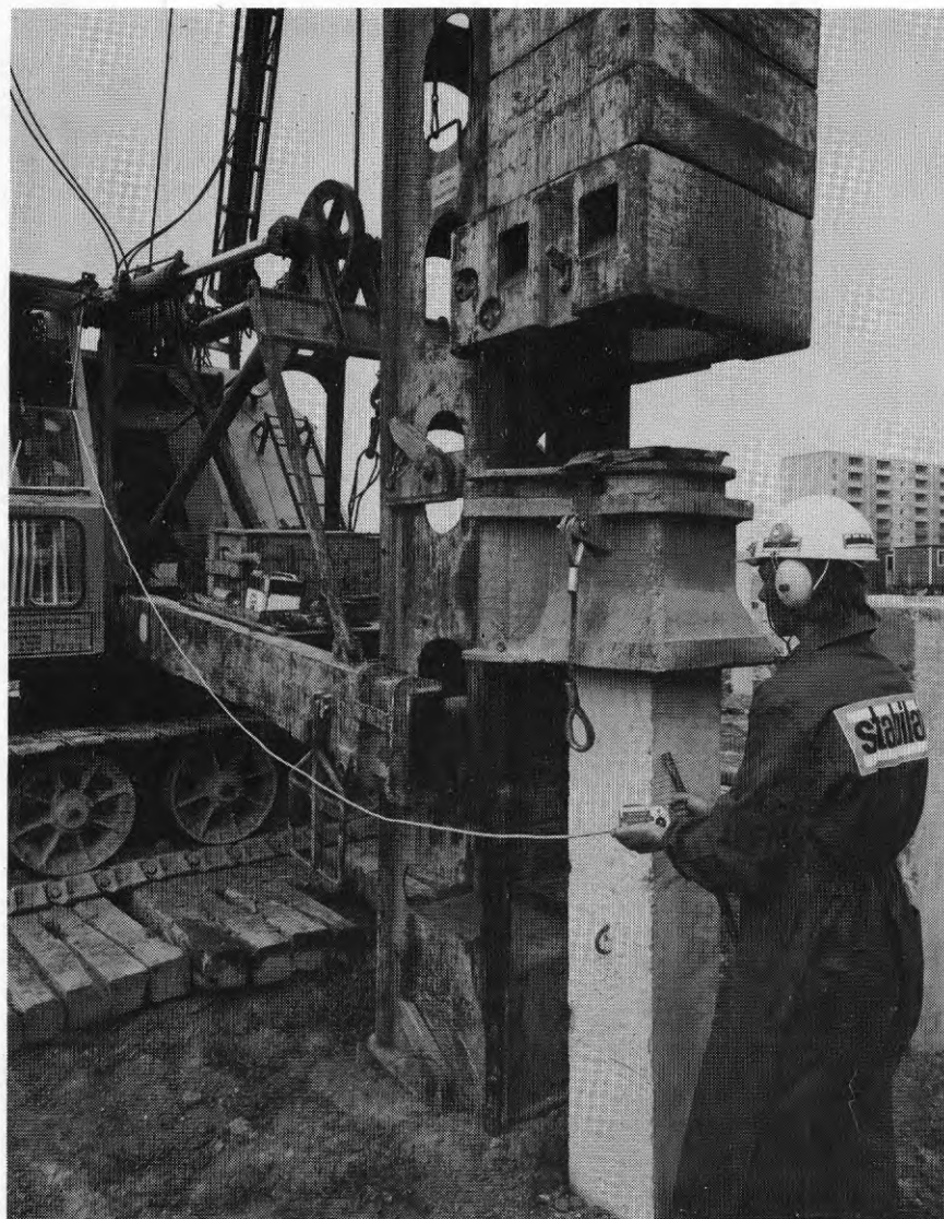
FIG. 1. Påslagning med automatisk manövrering.
