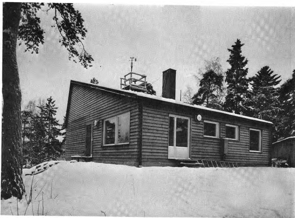
FIG. 6. Det färdiga huset sett från norr. Instrumenten på väggarna registrerade den totala solinstrålningen mot respektive fasad. På den särskilda träbryggan på taket var bl. a. en vindmätare uppsatt.
