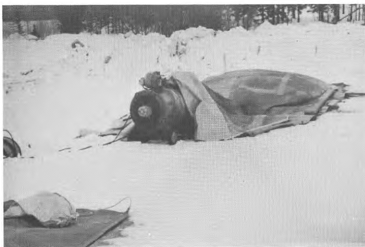
Fig 80 Vinterarbeten. Upptining före schaktning för ledningar.
