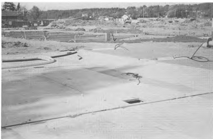
Fig 75 Kryprumsgrund. Bjälklag av prefabricerade betongplattor.
