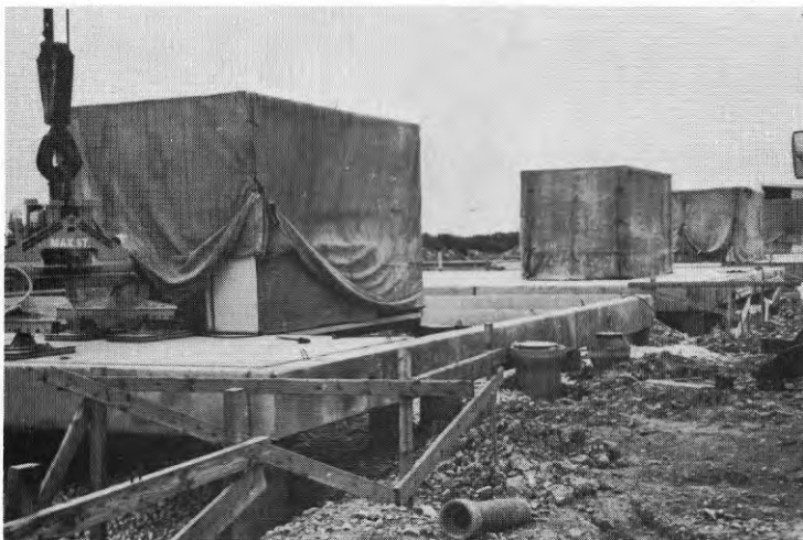
Fig 77 Kryprumsgrund. Prefabricerade balkar, bjälklag och volymselement för hygienutrymmen, s k "hjärtan".
