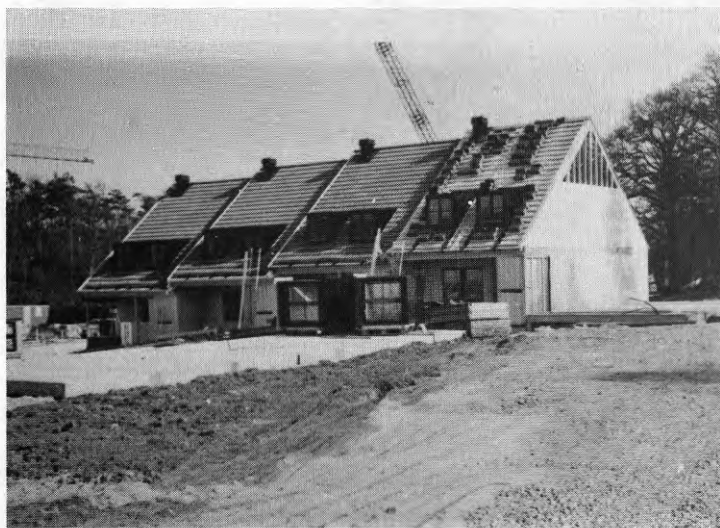
Fig 86 Småhus med kryprumsgrund. Nivåskillnader i kuperad terräng.
