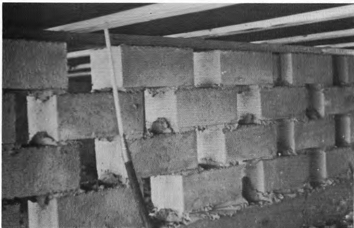
Fig 78 Kryprumsgrund. Murade väggar vid öppen ventilation.
