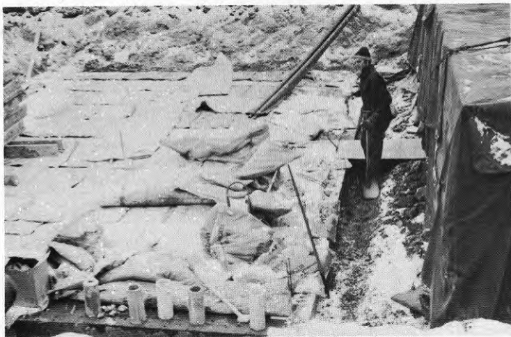
Fig 81 Vinterarbeten. Skyddstält för betonggjutning. Skyddsintäckning av den nygjutna betongplattan.
