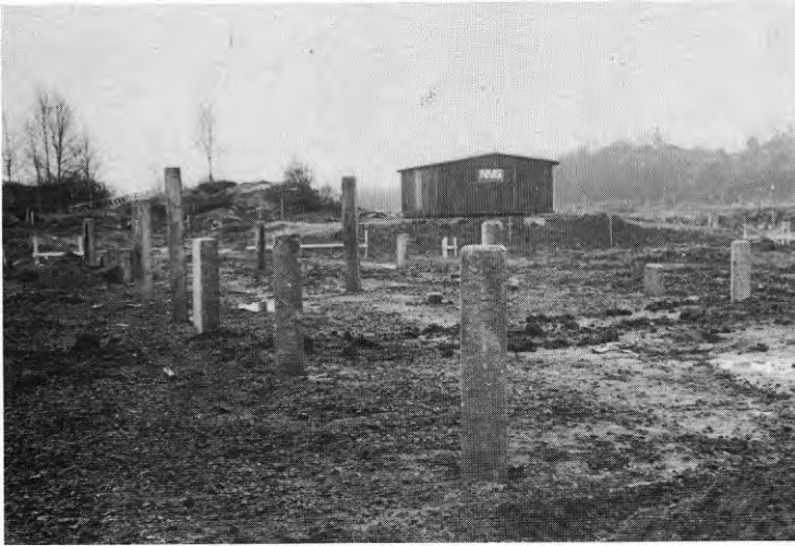
Fig 65 Arbetsplats i västsvenskt område. Markbehandling i lös lera på hösten. Stödd grundläggning med pålar.
