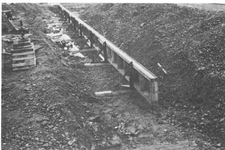
Fig 68 Platta på mark, mineralullsskiva under. Form av trä för kantbalk.
