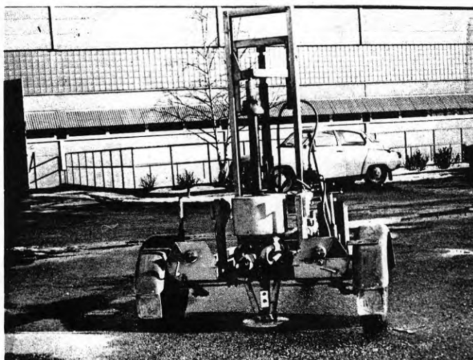
Figur 15: VTI-s fallviktsutrustning i mätläge. (Efter O. Tholén.)
