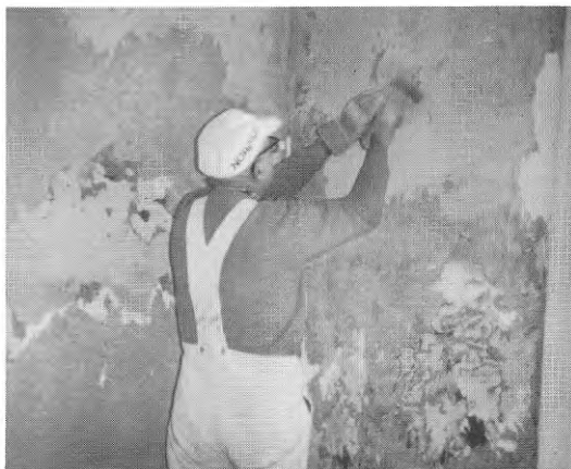
FIG. 3.10. Bortrivning tapeter med stålspackel.
