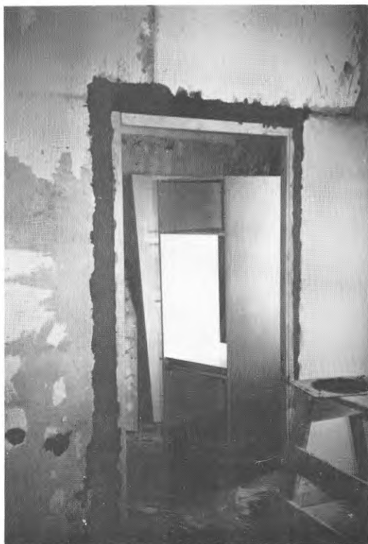
FIG. 3.13. Puts kring utbytt dörr.
