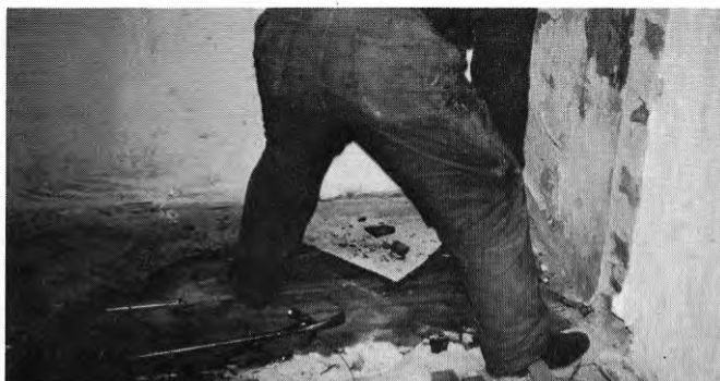
FIG. 3.8. Bortrivning gjutasfalt.
