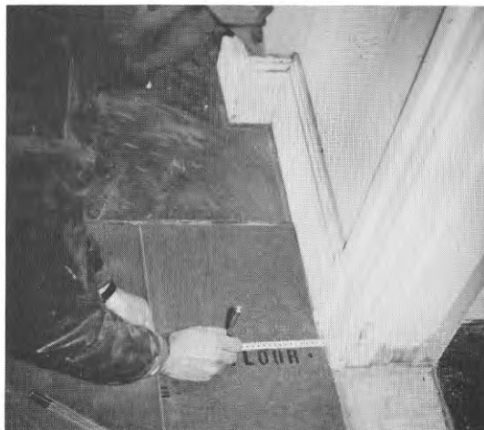
FIG. 8.7. Läggning träfiberskivor.
