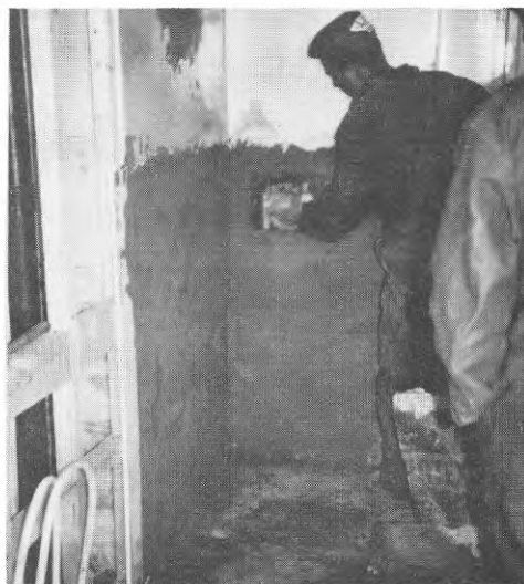
FIG. 5.2. Putslagning.
