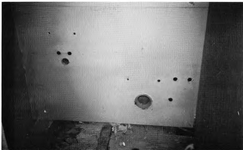
FIG. 13.8 Vägg på plats, duschrumssidan.
