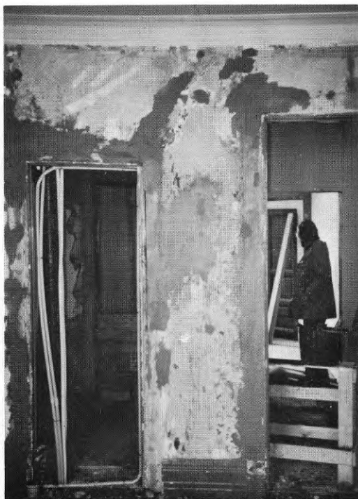
FIG. 5.3. Putslagning kring dörrar.
