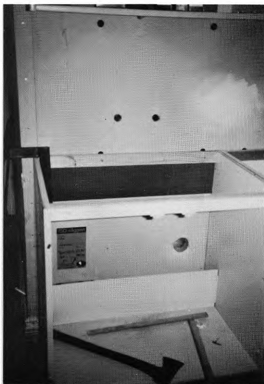
FIG. 13.9. På andra sidan finns uttag för köksavlopp, diskbänksblandare, belysning o.d.
