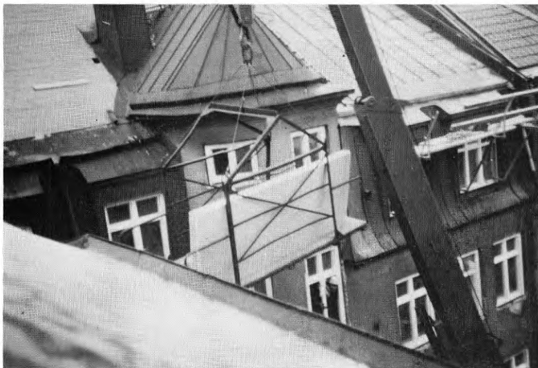
FIG. 2.9 Intagning av gipsskivor med mobilkran.
