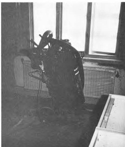
FIG. 6.17. Utrustning för drevning med polyuretanskum.
