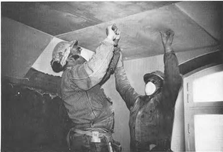
FIG. 9.5. Spikning gips i undertak.
