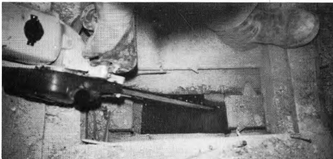
FIG. 2.4. Håltagning i träbjälklag med hjälp av motorsåg.
