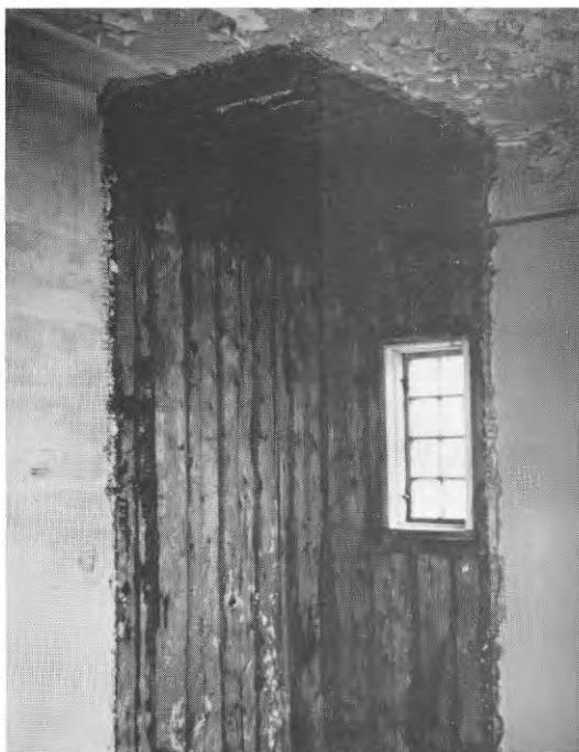
FIG. 3.11. Efter rivning av skaffer.
