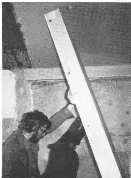
FIG. 13.6. Två man reser väggen utan besvär.
