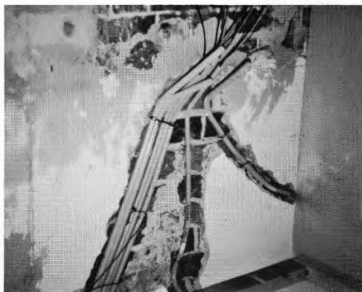
FIG. 14.5. Infällda ledningar. Objekt B
