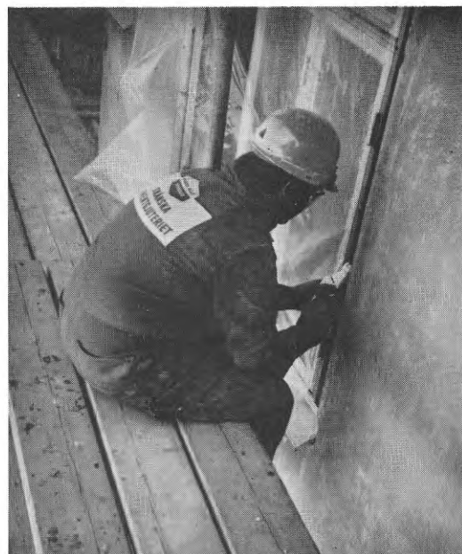
FIG. 6.18. Drevning utifrån.
