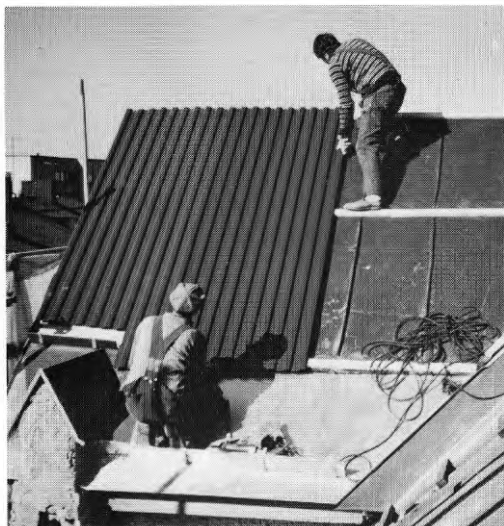
FIG. 16.1 Bild från tak objekt A
