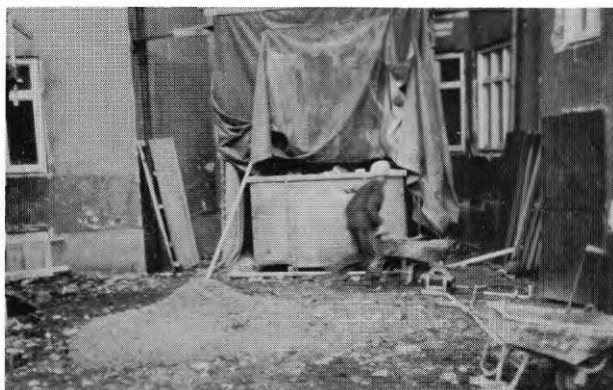
FIG. 2.7. Stört mynnar i kringbyggd container.
