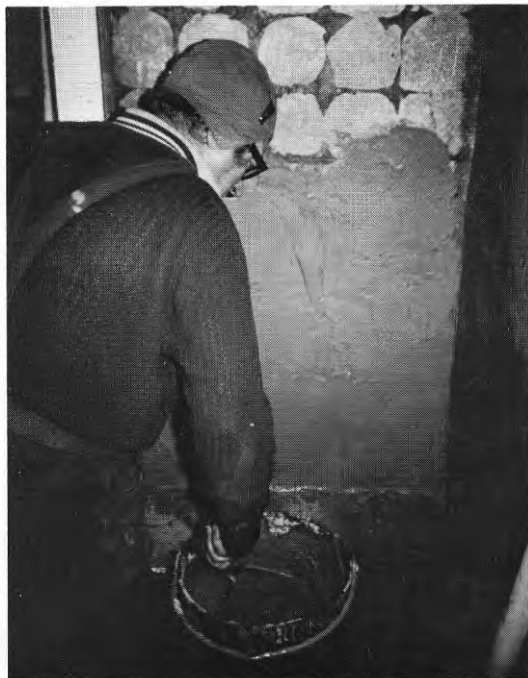
FIG. 5.6. Putsarbete - obekväm arbetsställning.
