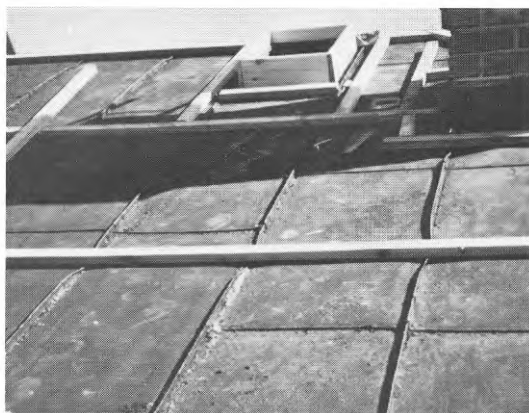
FIG. 16.3. Falsen nedknackad och reglar spikade.
