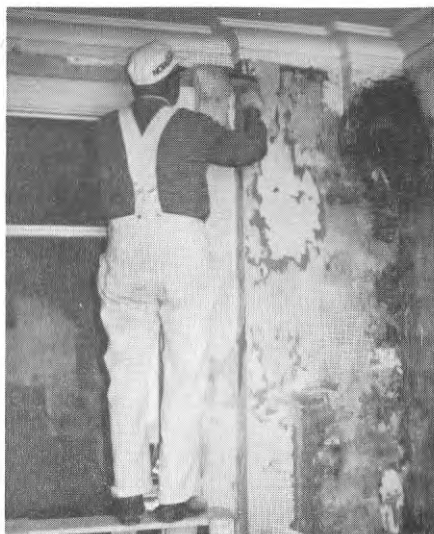
FIG. 15.1. Nedrivning tapeter med stålspackel.
