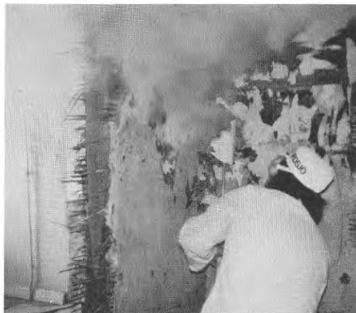
FIG 15.2. Nedrivning tapeter med ånga.
