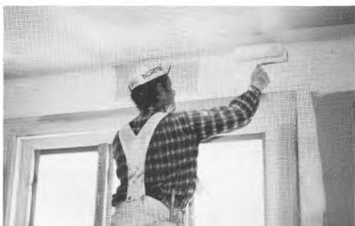
FIG. 15.6. Strykning i tak.
