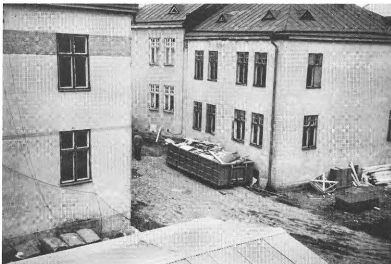
FIG. 12.1. Avfallscontainer nedanför 4 lägenheter.
