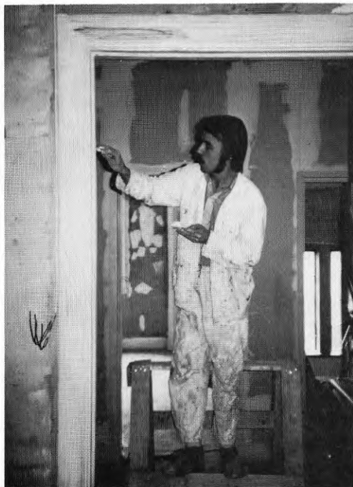
FIG. 15.7. Spackling gamla dörrsnickerier.
