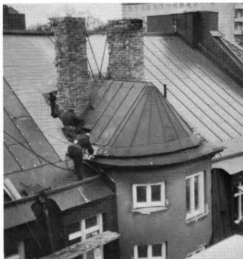
FIG. 16.2 Bild från tak objekt B
