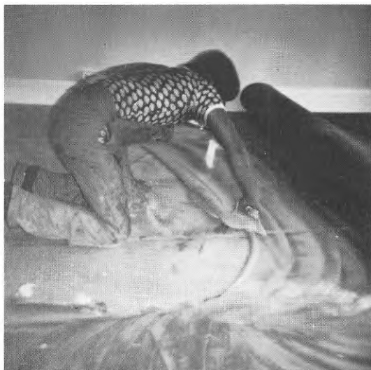
FIG. 8.15. Utspackling golv för mattläggning.
