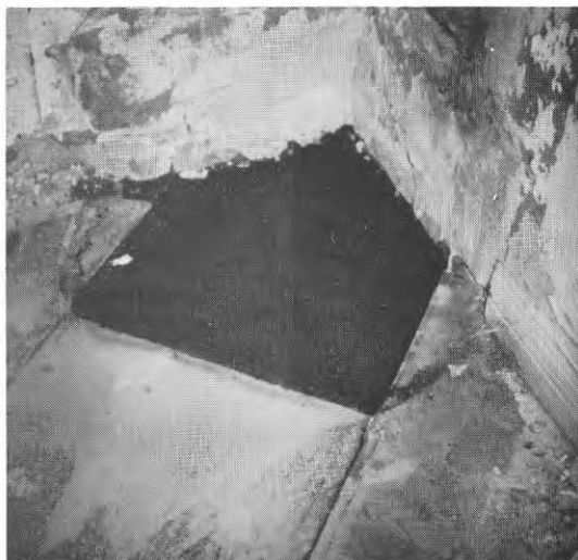
FIG. 3.12. Igengjutning golv efter bortriven kakelugn.
