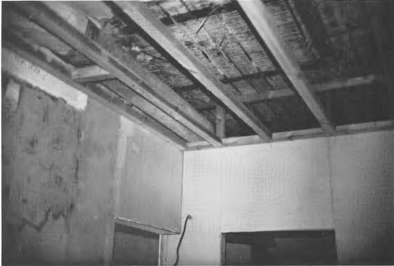
FIG. 9.4. Undertak, uppreglat.
