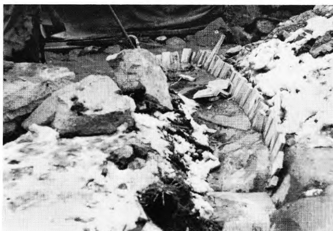
FIG. 57. Med tråkilar och trasor söker man förhindra att injekteringsbruket sprutar ut.
