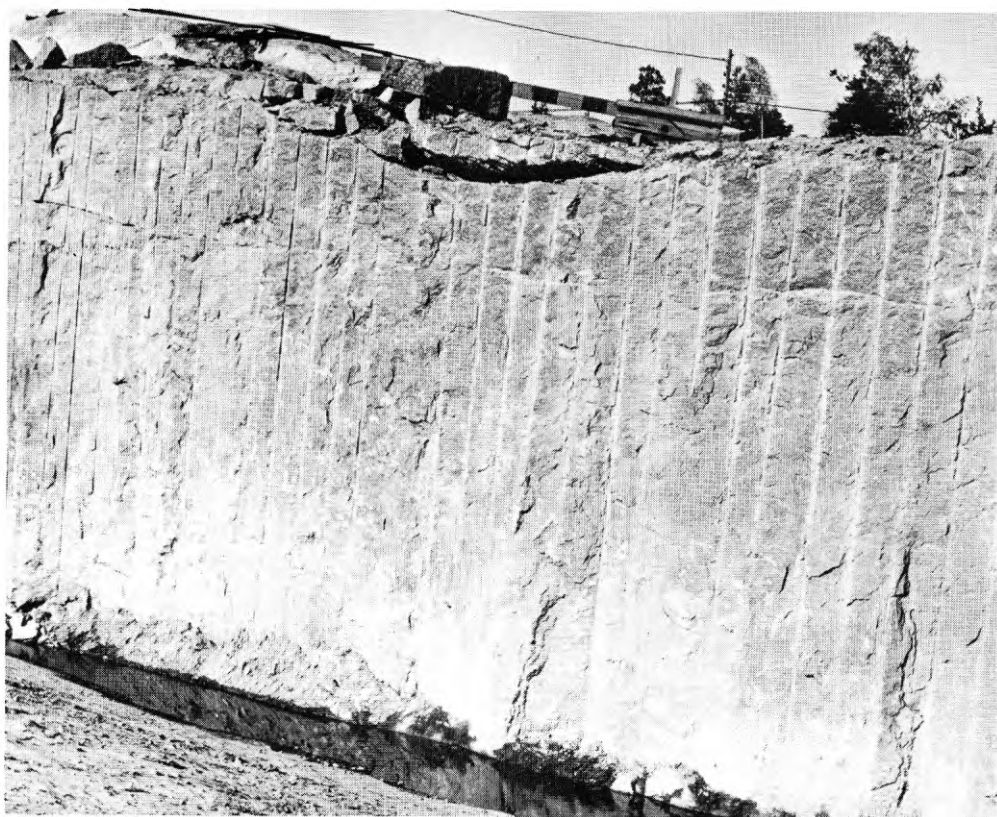
FIG. 25. Ett sprickfritt parti i granit är ovanligt.
