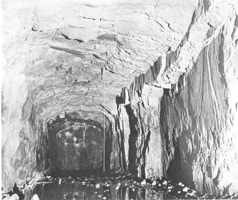
FIG. 23. Bergtunnel i granit parallell med huvudsprickriktningen.
