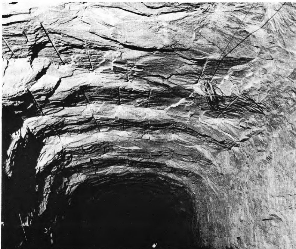
FIG. 49. Tunnel i granit. Taket är nära nog sprickfritt även efter sprängningen.
