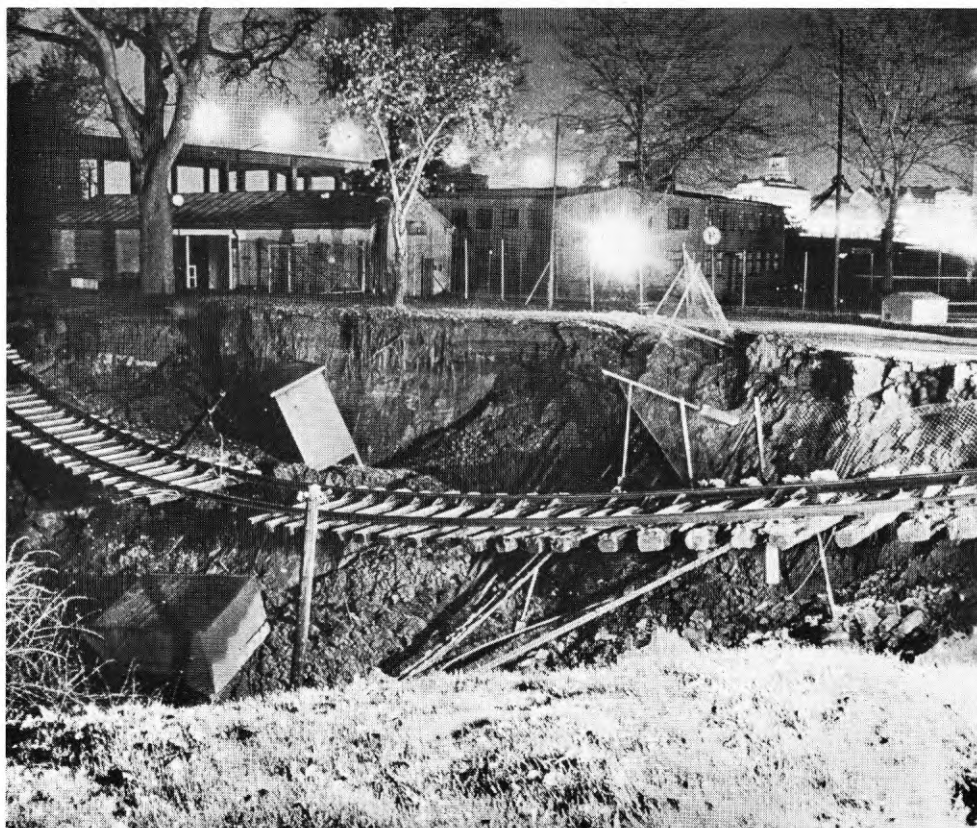
FIG. 4. Vatten- och jordgenombrott i kabeltunnel vid Hammarbyförkastningen 1965.
