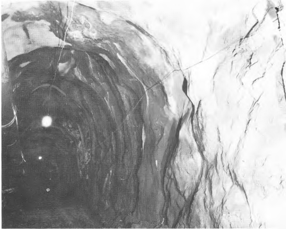
FIG. 55. Tunnel i dåligt berg förstärkt med sprutbetong och sprutade bågar.
