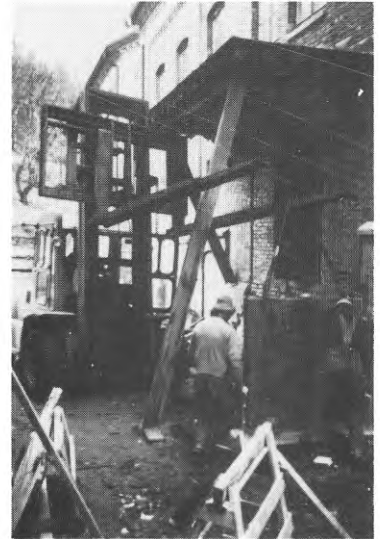
Inplacering av trapplöp på plats.
