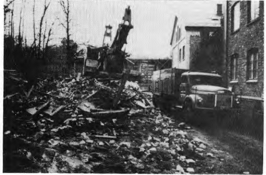
Gårdsbyggnader revs med grävmaskin.
