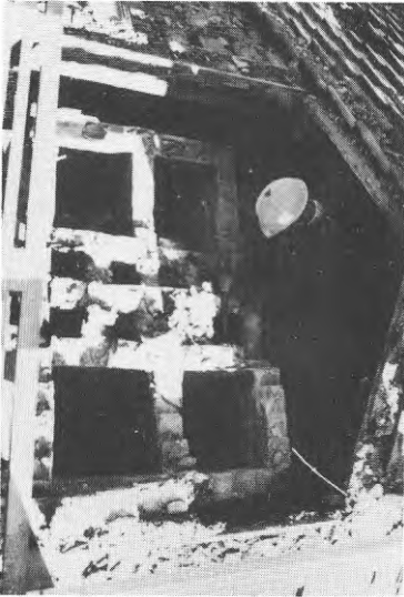
Handbilning i kombination med tryckluftsmejsling.
