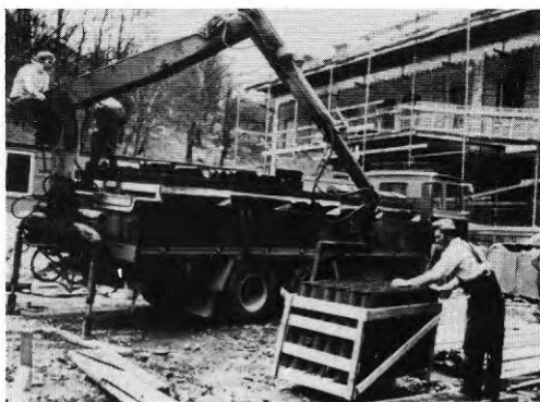
Pallade takpannor lossas med bilkran.
