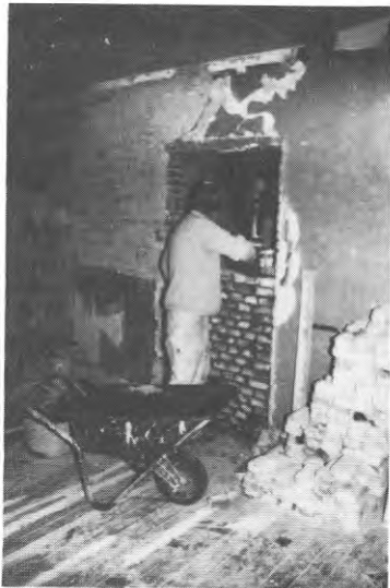
Igenmurning med återanvänt tegel.
