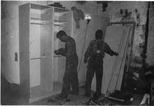
Garderobsinredning med förtillverkade och färdigmålade enheter.
