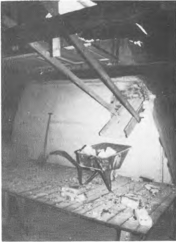
Handbilning och störtning via slas till kärra. Uppskyffling i kärra av material som ramlat utanför.
