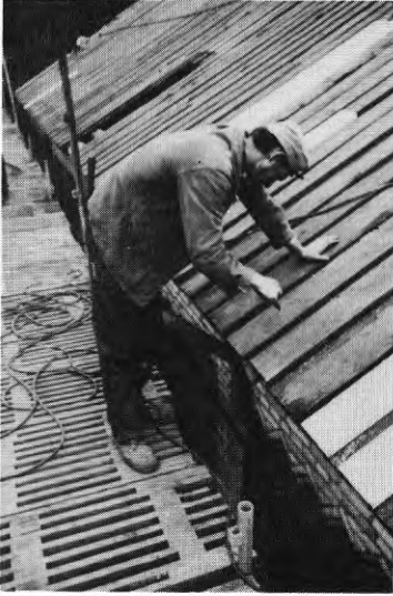
Manuellt utbyte av rötskadad takpanel.
