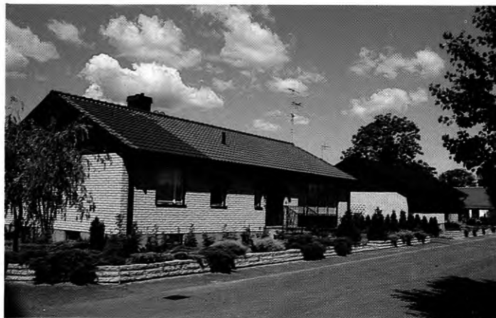
Fig. 1. Betongtakpannor illustrerar ofta kalkutfällningsproblemet. Ett svart tak som blev vitt gläder sällan ägaren av en vacker villa. Att grannens betongtakpannor är vackert svarta är en klen tröst. Ofta är det ännu värre om taket endast delvis fått utfällningar. Det kan ta flera år innan en kalkutfällning försvinner.
