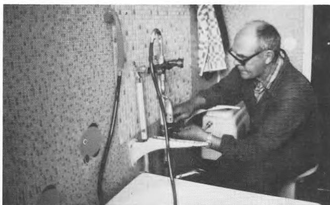
FU-reparatör som byter duschslang.
