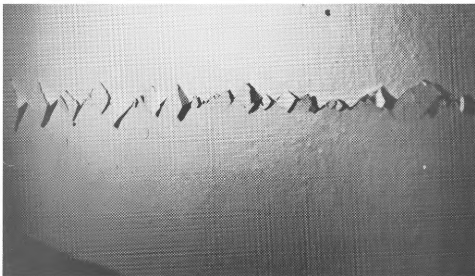
FIG. 24. Rum 3:7 södra väggen sick-sack-format sprickmönster efter salva 2.
