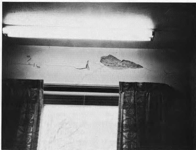
FIG. 17. Rum 2:1 östra väggen efter salva 3.
