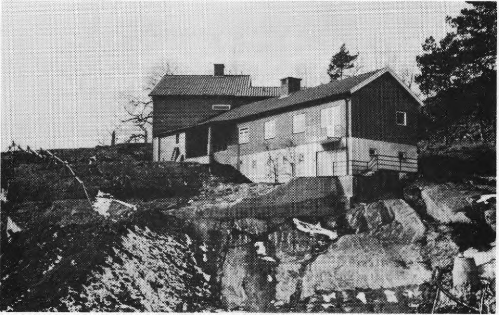
FIG. 5. Försökshus före sprängningarna.
