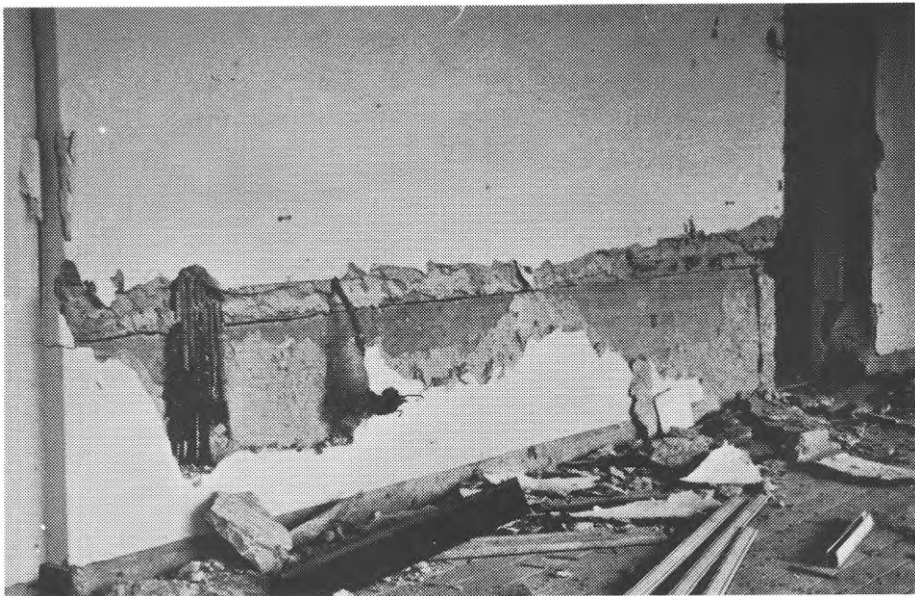
FIG. 21. Rum 3:6 norra väggens stomkonstruktion frilagd efter sista salvan.
