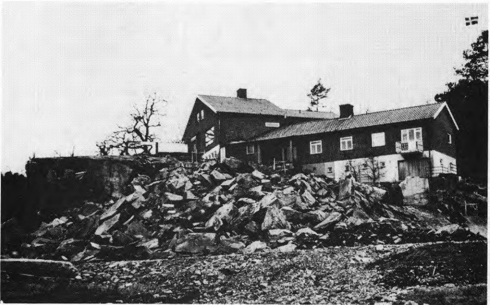
FIG. 6. Försökshus efter tredje sprängningen.
