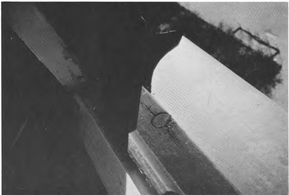
Bild 10 och 11. Kvistlagning i karmbottenstycke och karmsidstyckets nedre del. Här borde man ha använt virke som inte behöver lagas.
