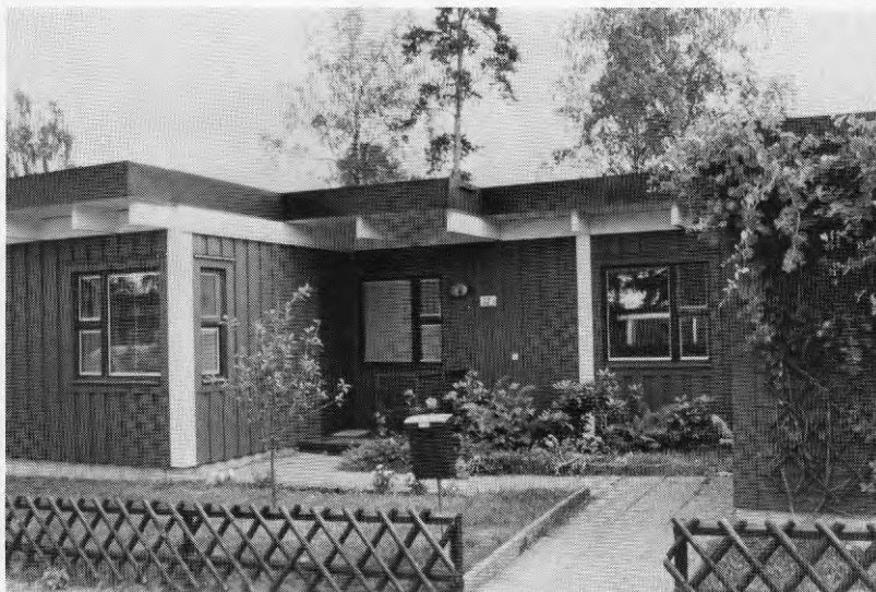
Bild 1. Kv Spiran, augusti 1985. (Foto Magnus Nordström)
