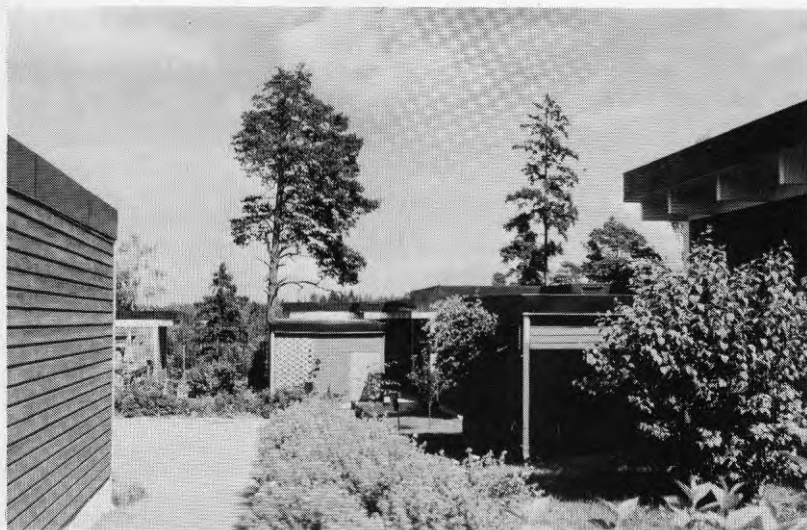
Bild 3. Kv Spiran, augusti 1985. (Foto Magnus Nordström)
