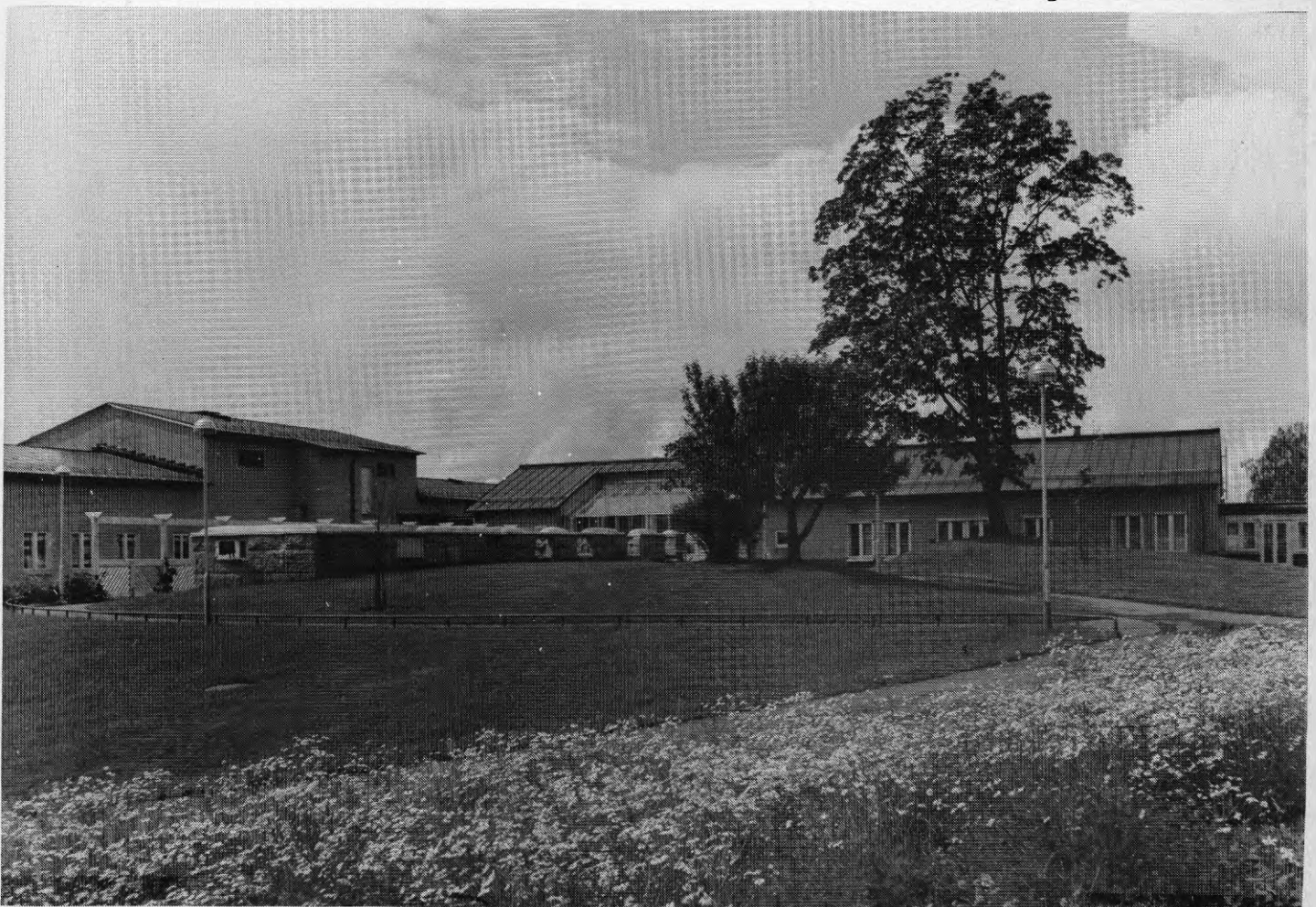
bevarad "ruin" mot Stockholmsvägen
