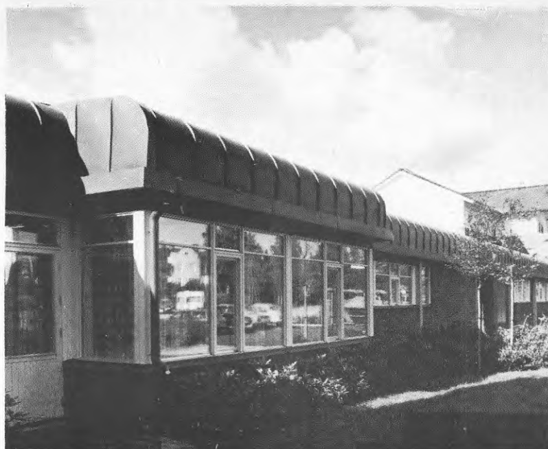
Envåningsbyggnaden med de gemensamma lokalerna
